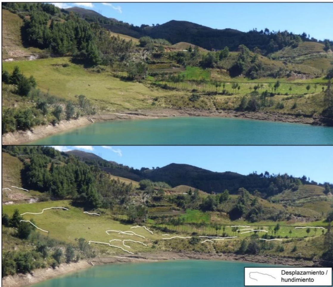
Figura 16. Desplazamientos y hundimientos en el sector noroeste del embalse Río Grande (foto inferior interpretada).
