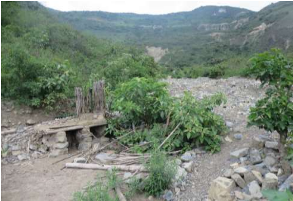
Foto 06: Vivienda próxima a la quebrada Porongos y destruida por los flujos de detritos.
