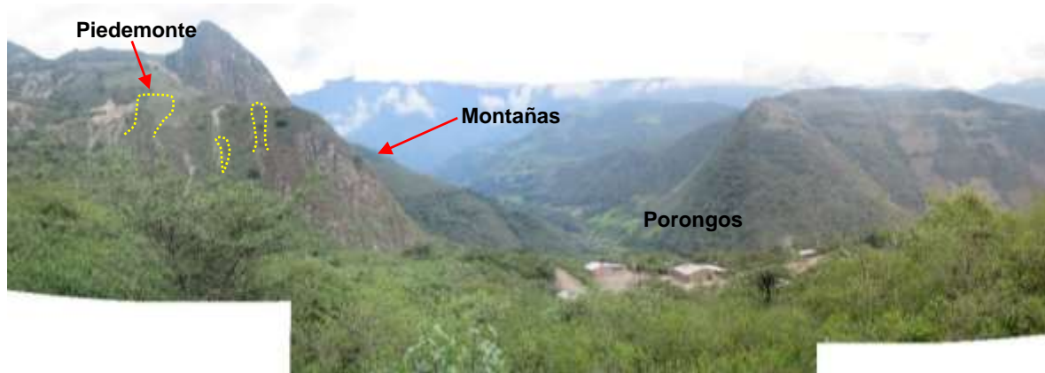
Foto 01: Vista panorámica del caserío Porongos ubicado sobre las laderas de montañas y piedemonte coluvio-deluvial en la parte alta
