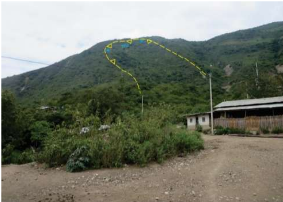
Foto 02: Vista del deslizamiento antiguo, se localiza en la parte alta del caserío Porongos
