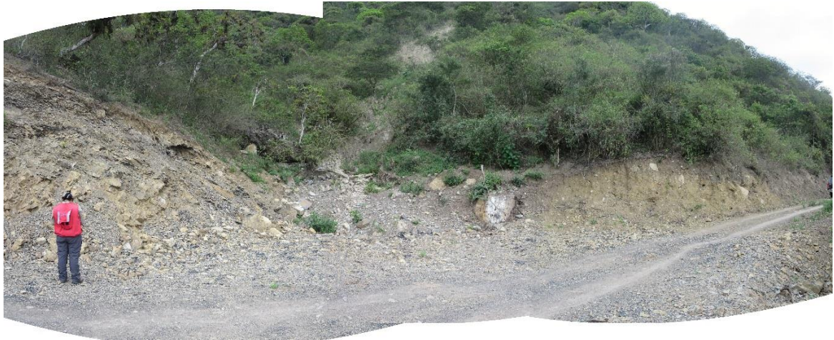
Foto 08: Vía de acceso a Palo Blanco afectada por flujos de detritos canalizados por la quebrada Los Cunos.
