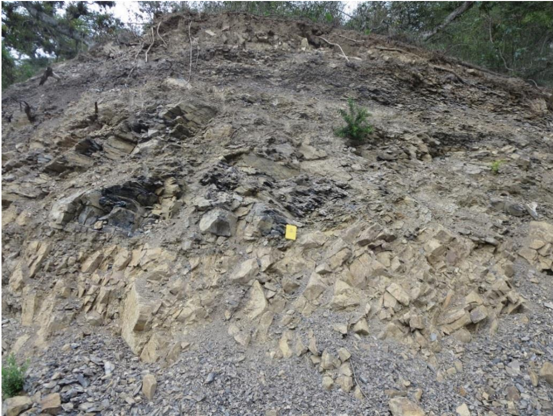
Foto 02: Calizas arenosas color amarillento intercaladas con calizas mudstone a wackestone, color negro bituminoso de la Formación Inca-Chúlec, muy fracturadas con cobertura superficial coluvial, generando caída de rocas o derrumbes localizados.
