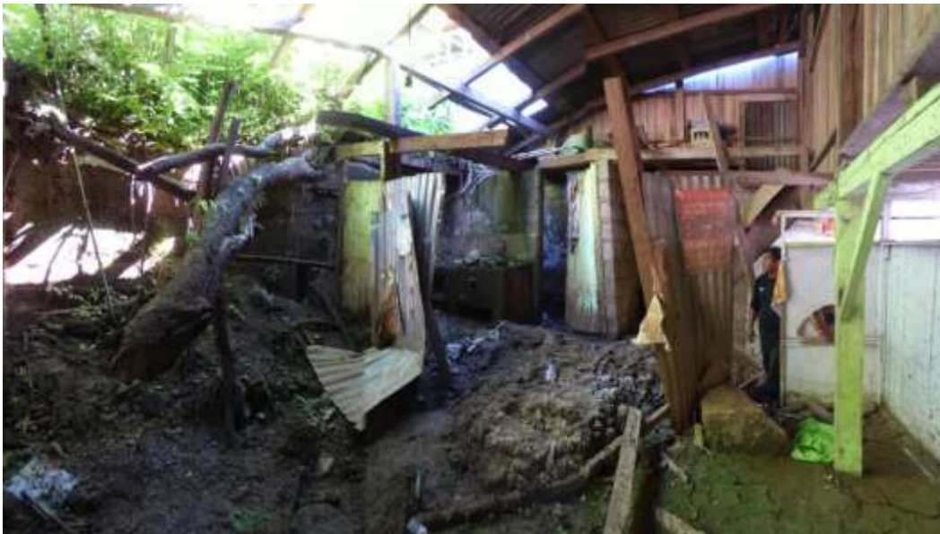
Foto 5. En la imagen se puede ver los daños ocasionados en una vivienda de la comunidad de Puente Capelo; se observan troncos, algunos bloques y lodo, que fueron transportados por la avalancha de detritos.
