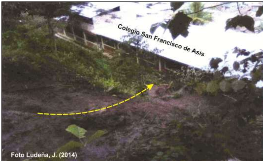
Foto 6. Avalancha de detritos que afectó al colegio San Francisco de Asís.
