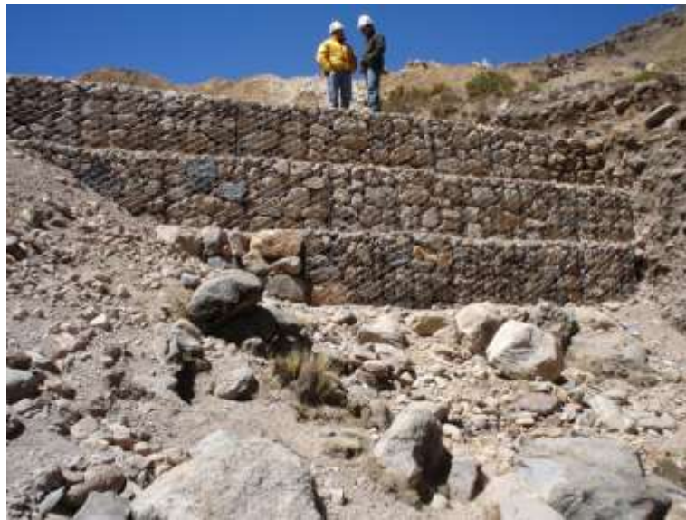
Foto 20. Dique transversal con muro de gaviones en gradería.
