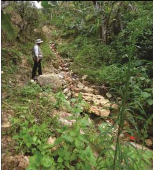
Foto 11. Cauce de la quebrada Rodas, con material suelto de fácil remoción.
