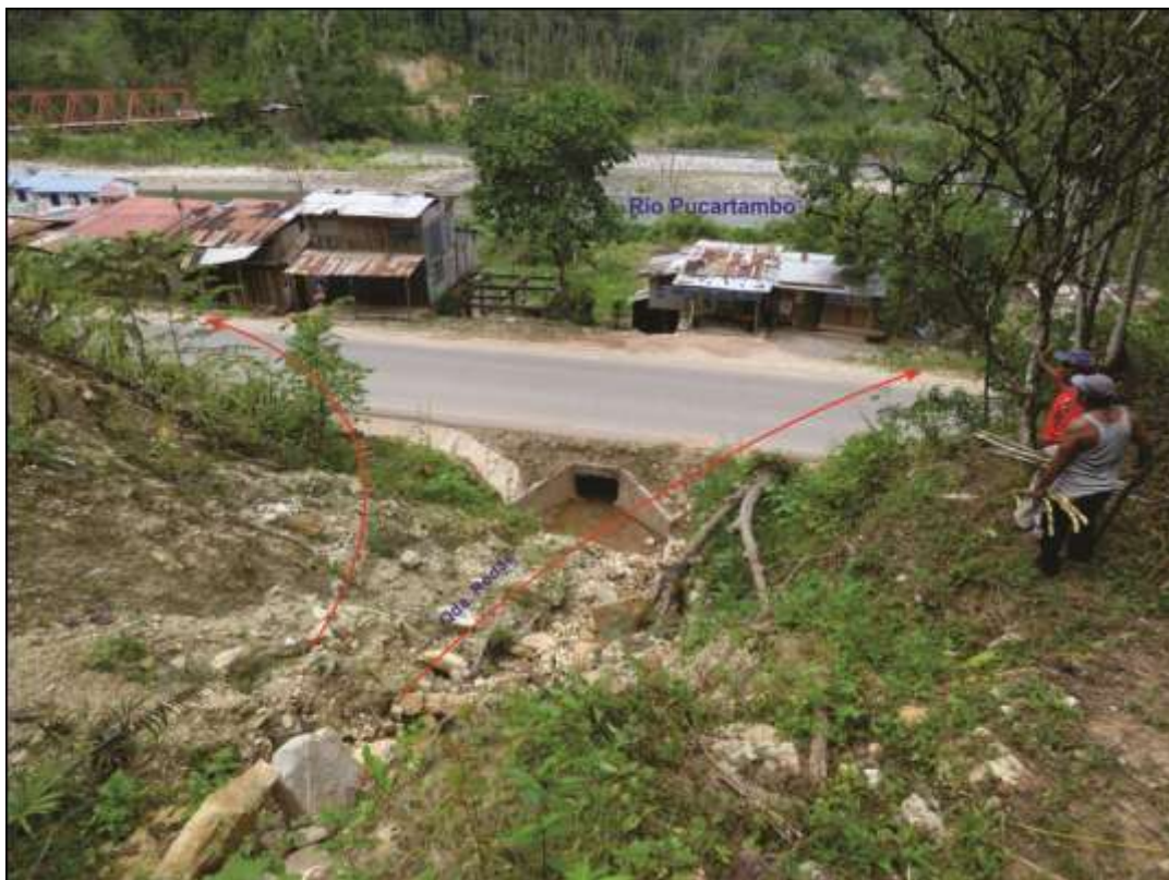
Foto 9. Viviendas que ocupan la desembocadura de la quebrada Rodas.
