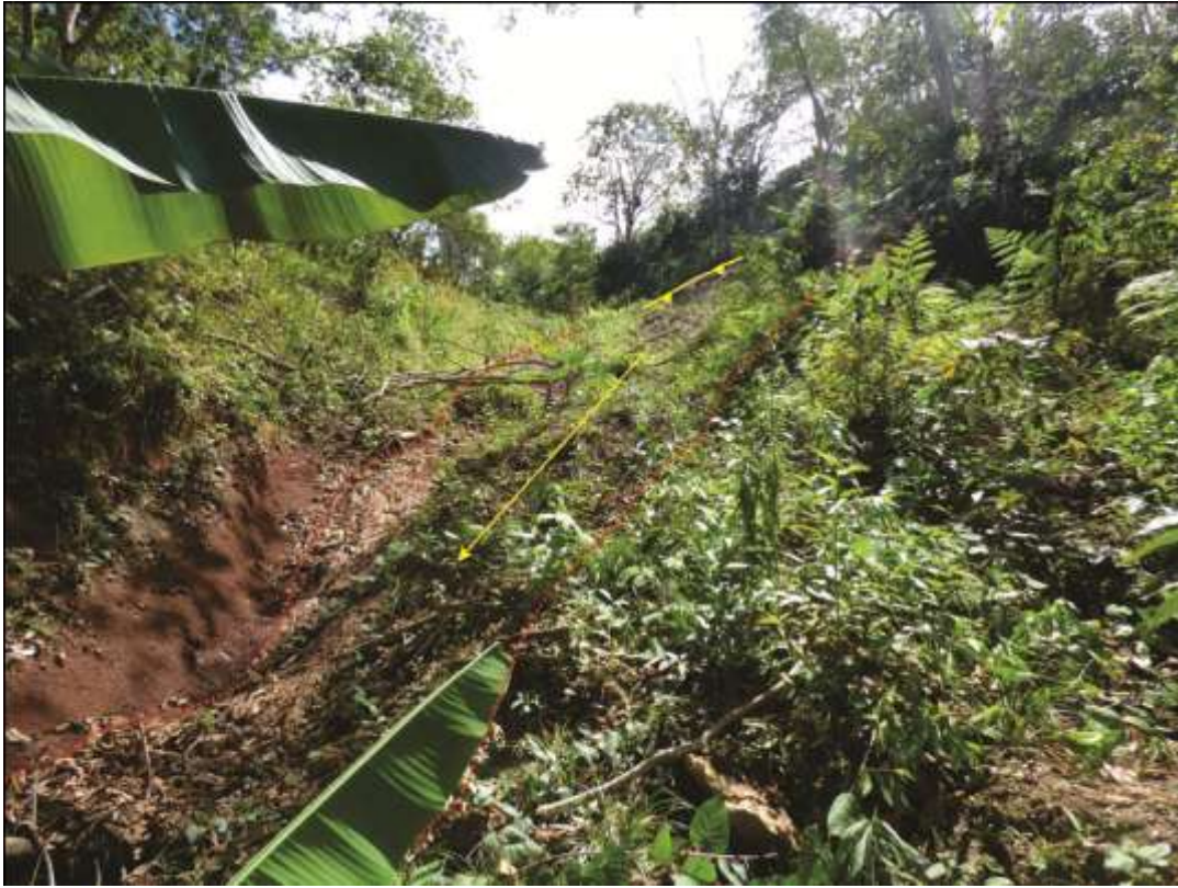
Foto 13. Se aprecia parte del material deslizado, que cubrió parcialmente el cauce de la quebrada Rodas.
