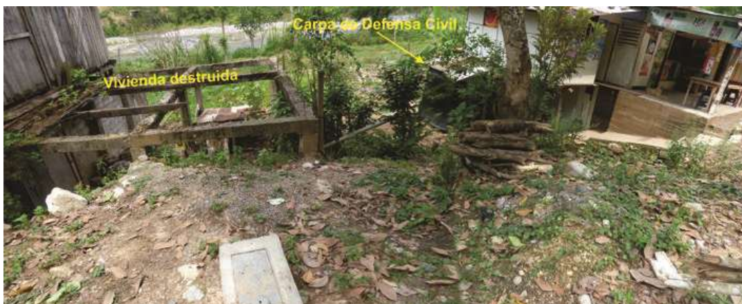
Foto 10. Parte del área afectada por el último flujo de detritos.
