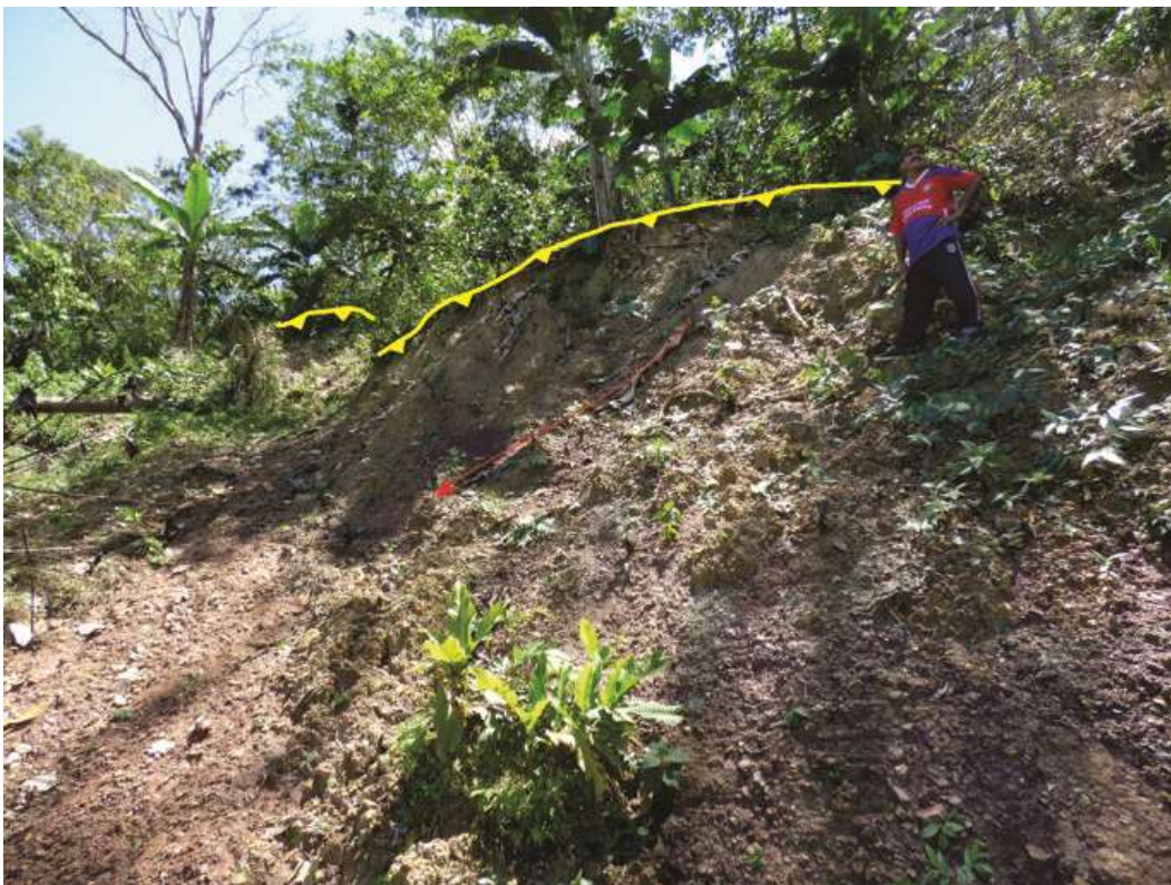
Foto 12. Deslizamiento rotacional, ubicado en la margen izquierda de la quebrada Rodas.
