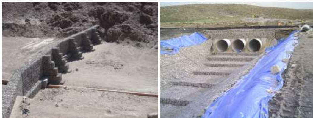
Fotos 22 y 23. Diques "semihuecos" o de retención selectiva. Con gradería canalizada para pérdida de la energía del flujo en los saltos sucesivos.
