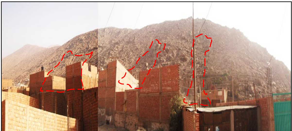
Figura 21: Caída de rocas en las inmediaciones de la Asoc. Viv. El Huáscar. Margen izquierda del río Rímac.
