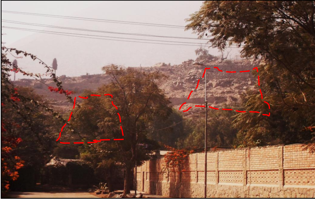
Figura 20: Caída de rocas en las inmediaciones del cerro de la Urb. 3 de Octubre. Margen izquierda del río Rímac.
