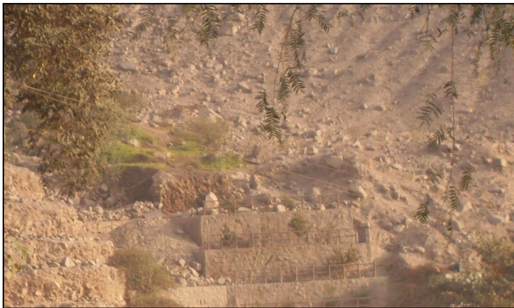
Figura 19: Muros de contención en la parte baja de la quebrada colindante a la residencial El Cuadro. El muro evita que las rocas sueltas, producto del flujo de detritos, alcancen la parte baja (carretera central).
