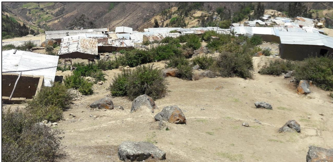
Foto 12: Depósitos coluviales en la vertiente norte del cerro Coronilla, susceptibles a la erosión.
