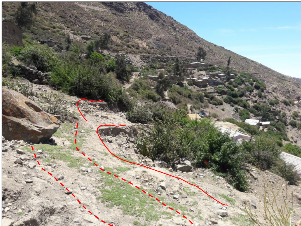
Foto 5: Grietas tensionales detrás del escarpe secundario.
