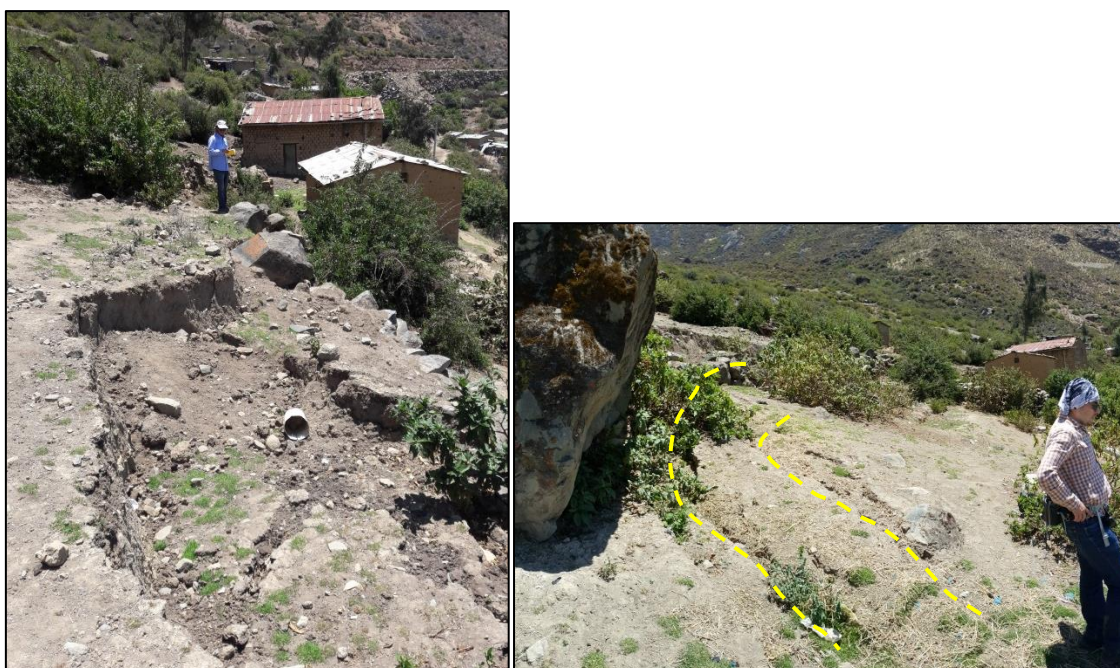
Foto 2: Corona del escarpe principal. Foto 3: Grietas tensionales debajo del escarpe principal.
