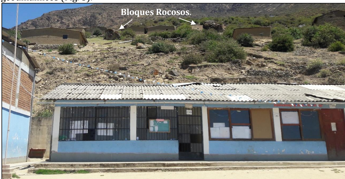
Foto 13: Construcción de nuevas viviendas sobre depósitos coluviales.
