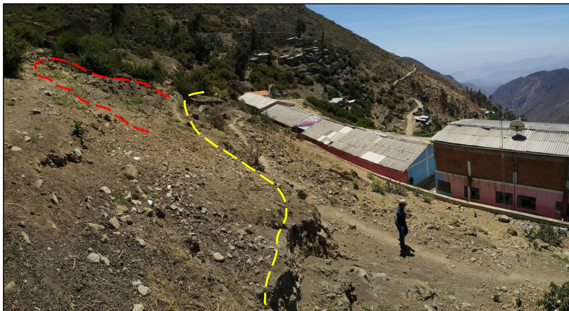
Fotos 6 y 7: Escarpe de erosión activo al pie del escarpe secundario del deslizamiento de Chaclancayo (línea roja).
