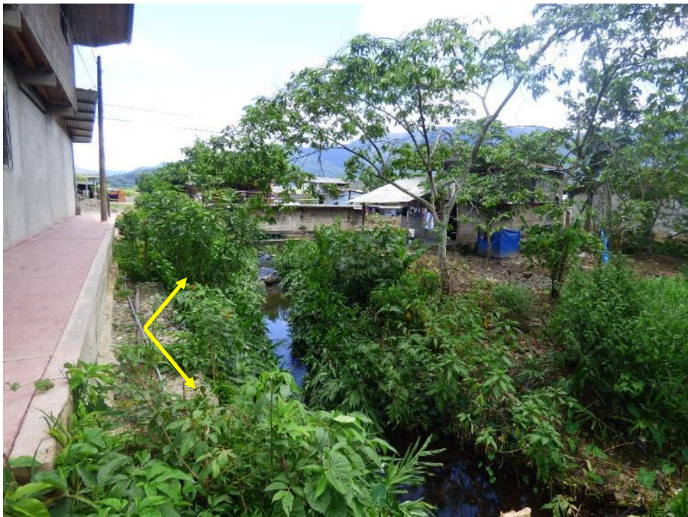
Foto 9. Gaviones construidos para evitar la erosión fluvial.
