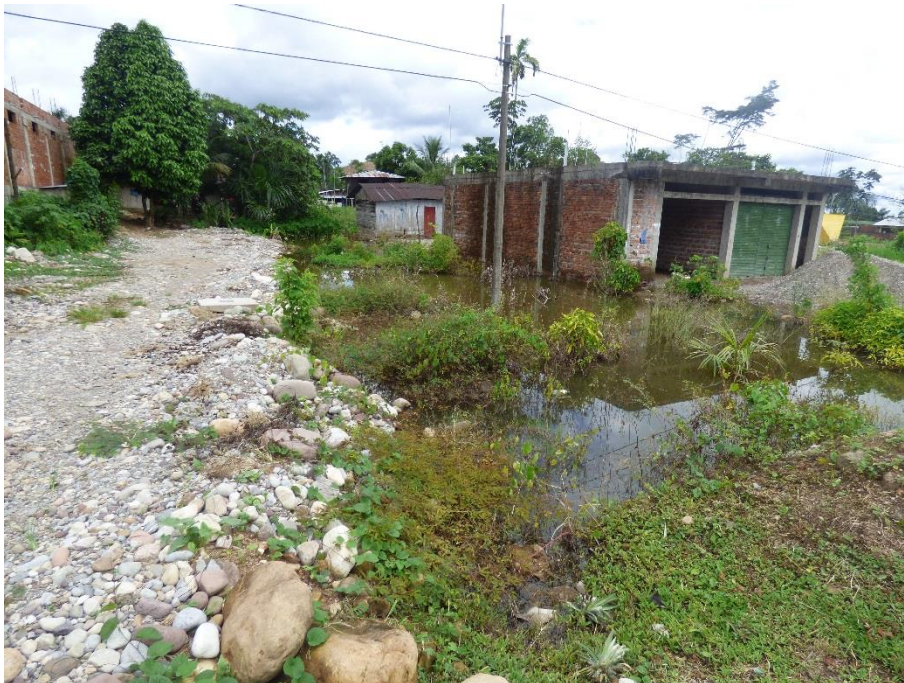
Foto 8. Viviendas ubicadas sobre un bofedal.
