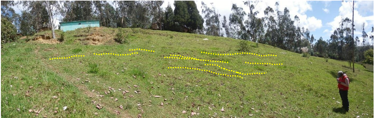
Foto 08: Reptación de suelos identificado en la parte alta del cementerio privado Nuevo Mundo.
