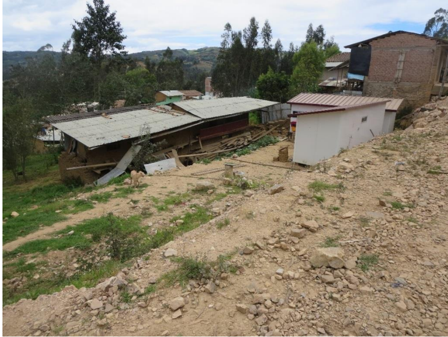
Foto 05: Viviendas afectadas por el deslizamiento, así como las viviendas temporales
