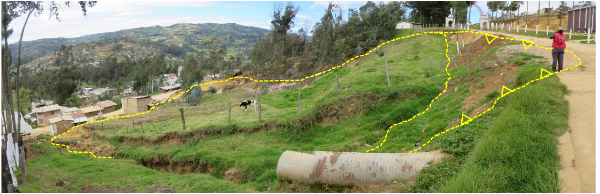
Foto 03: Vista panorámica del deslizamiento rotacional en el Barrio Carniche y Los Olivos
