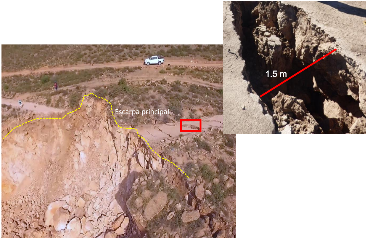
Foto 8 Vista de la carretera destruida por el avance de la escarpa principal del deslizamiento y agrietamientos en la corona del deslizamiento.
