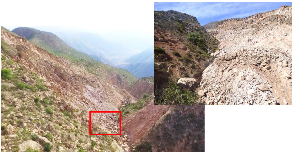
Figura 16: Vista del río Chaquihuayjo cubierto por detritos y rocas del deslizamiento, en junio de 2018.
