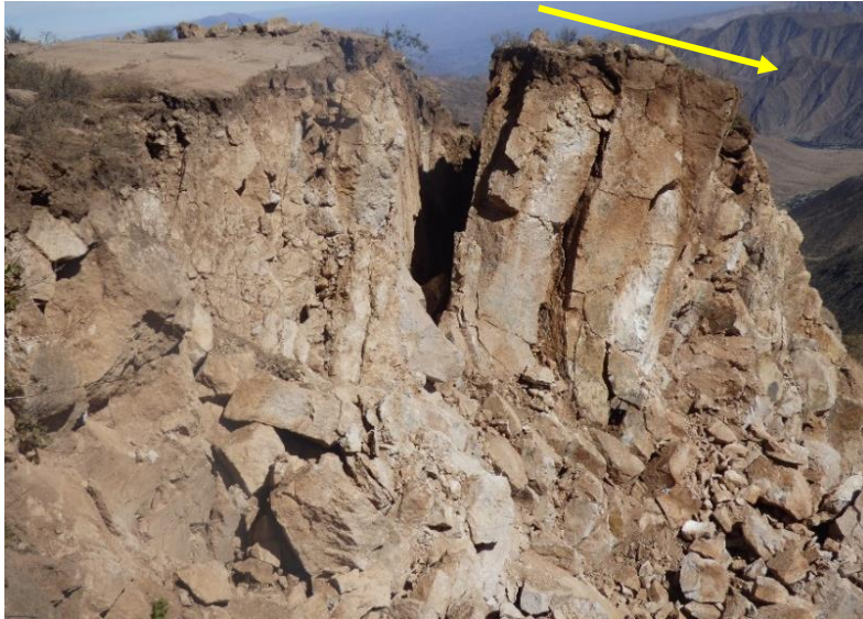
Foto 5: Desprendimiento de bancos de ignimbrita en la escarpa principal del deslizamiento de Chaquihuayjo.
