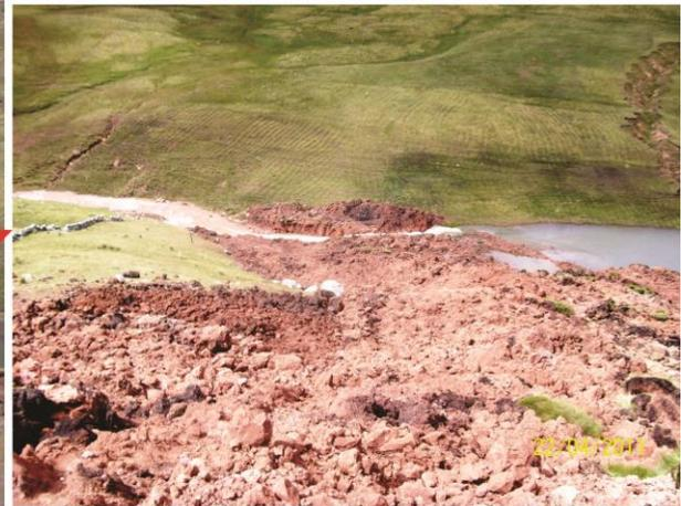
Foto 2: (A) Vista panorámica del Movimiento complejo (deslizamiento-flujo) de Santiago Pampa. (B) Vista del pie del movimiento complejo que se comportó como un flujo de lodo que destruyó la carretera y embalsó al río Andachaca.
