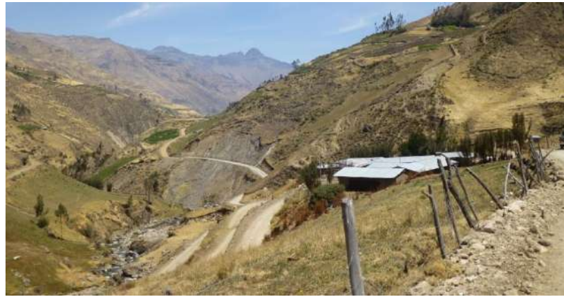
Foto 8. Deslizamiento reactivado a manera de derrumbes y reptación de suelos en talud superior de carretera Gorgor-Llocchi, sector Puente (Gorgor).
