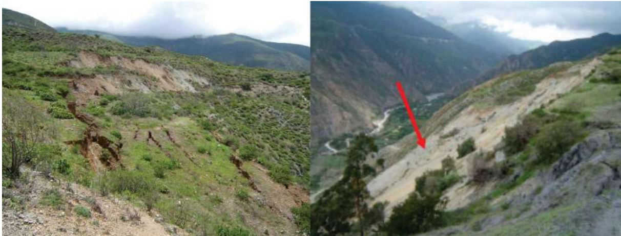
Foto 23. Agrietamientos en terrenos de cultivo en el sector Pucutura, con presencia de puquiales, en la margen izquierda del río Checras.
