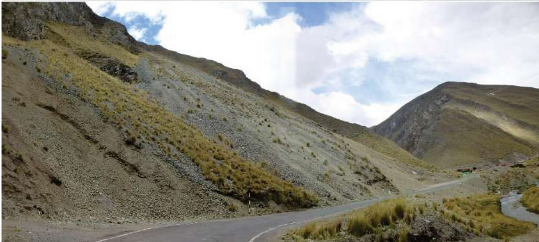
Foto 25. Derrumbes en talud superior de carretera Alis-Tinco y flujo de detritos en el sector Tinco (Yauyos).
