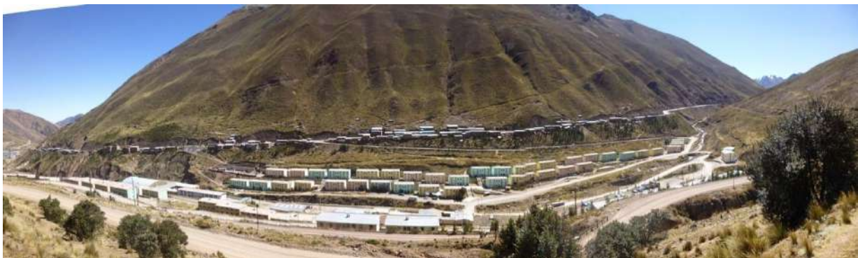
Foto 4. Erosiones de laderas que acarrear material de la ladera afectando a la carretera central y al campamento de Casapalca.
