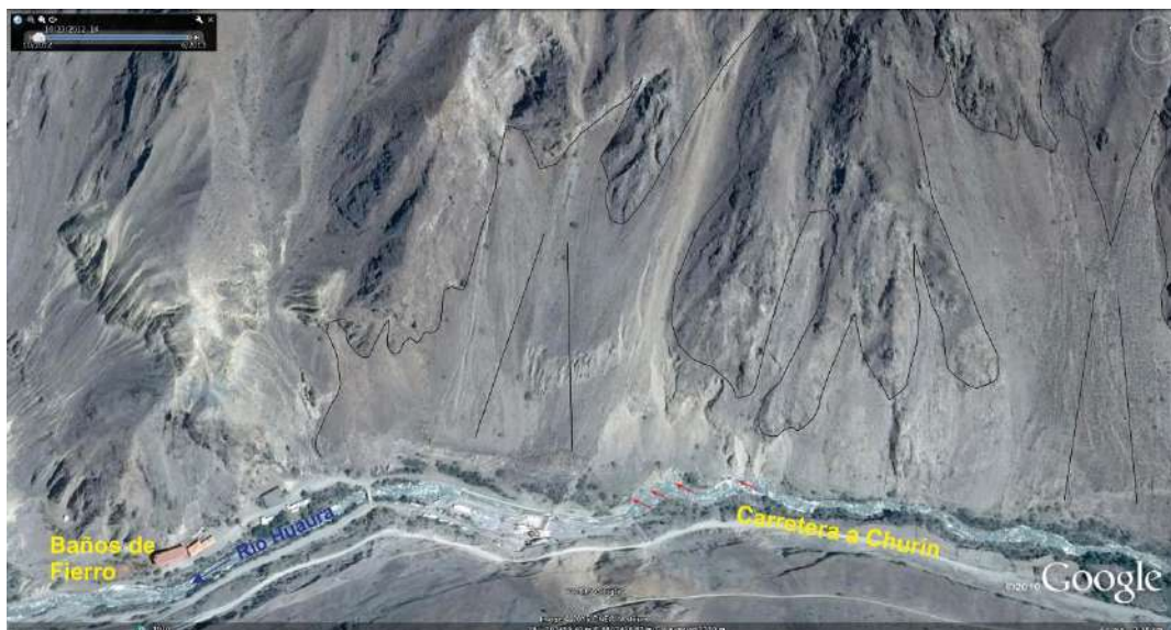
Figura 9. Sector de Cabracancha (Baños Termales de Fierro). Con presencia de erosión fluvial en la margen derecha del río Huaura, produce derrumbes por socavamientos del pie del talud.
