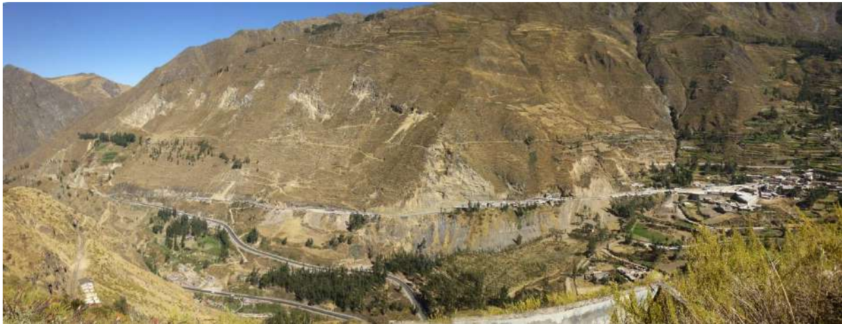
Foto 20. Derrumbes y deslizamiento en el cerro Pucruchacra, sector San Mateo.
