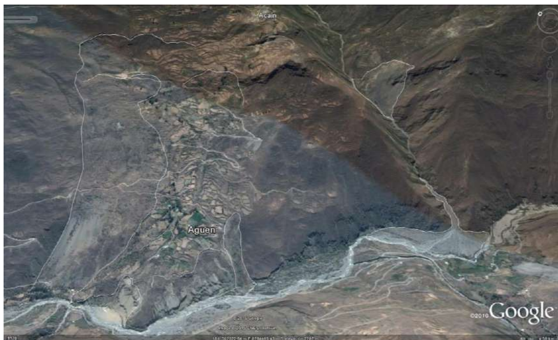
Figura 10. Deslizamientos y derrumbes en el sector Aguen, en la margen derecha del río Checras.
