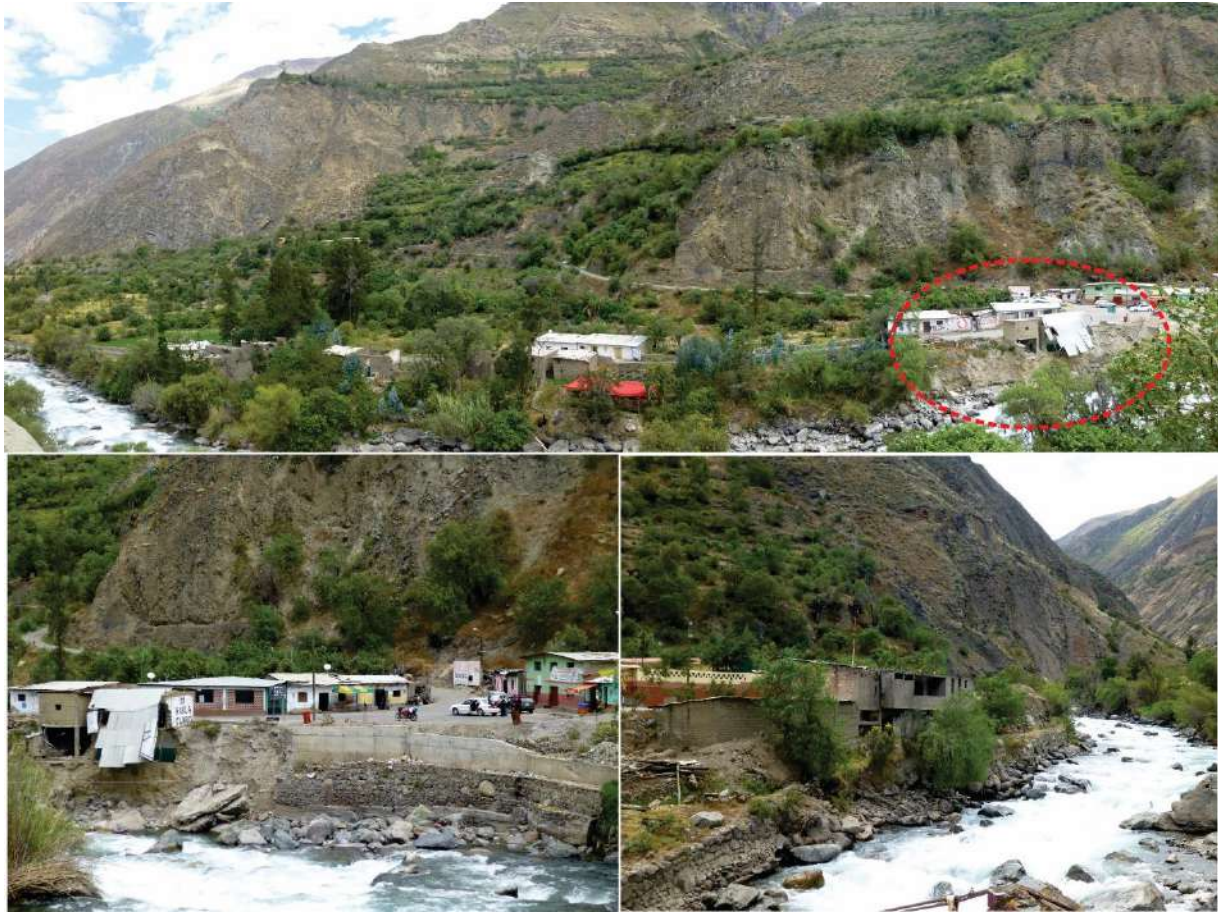
Foto 27. Erosión fluvial en margen derecha del río Cañete - Sector de Magdalena, al pie de un deslizamiento antiguo.
