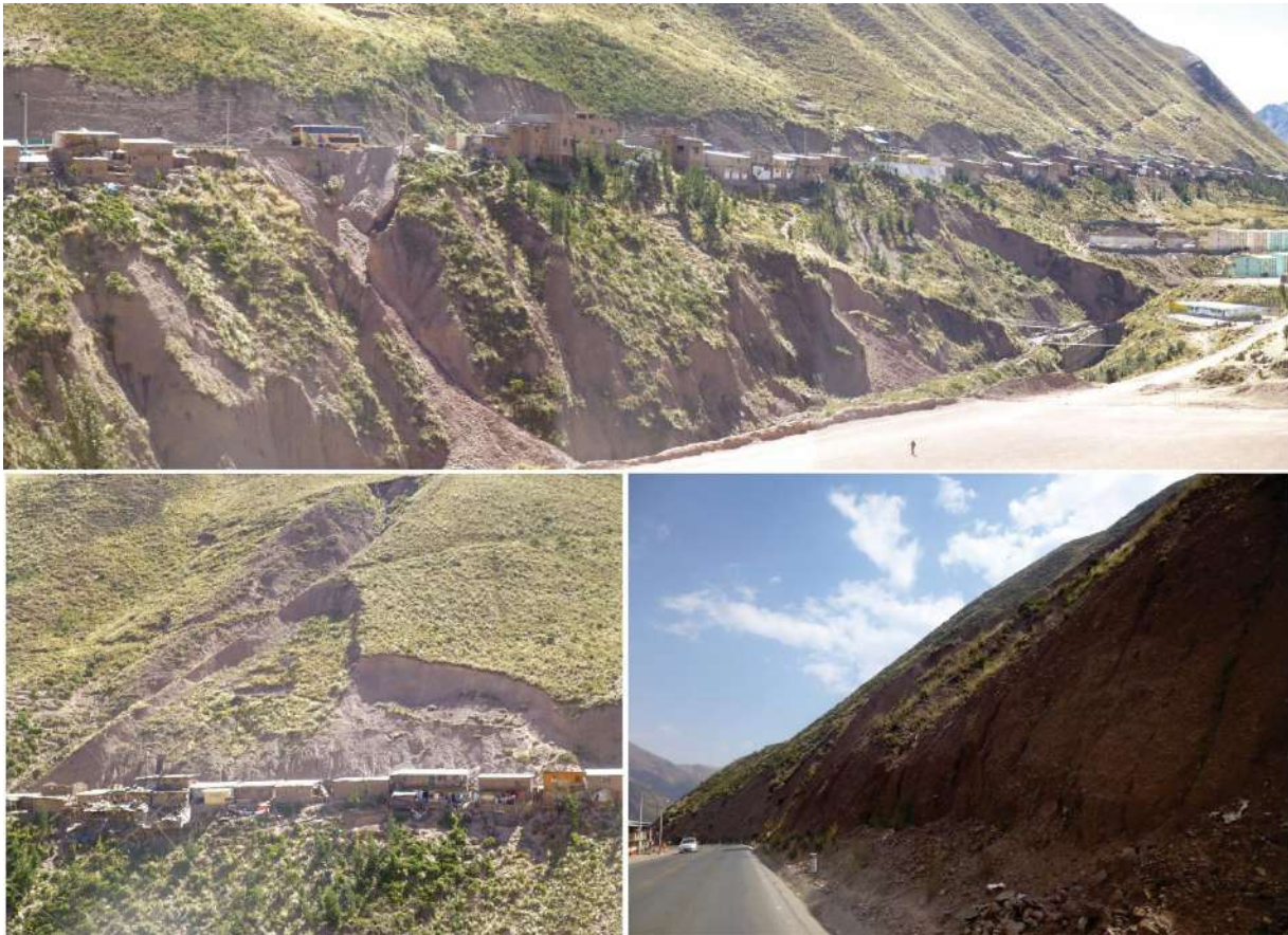
Foto 19. Derrumbes y erosión de laderas en el sector Casapalca, talud superior de la Carretera Central, km 117+000.
