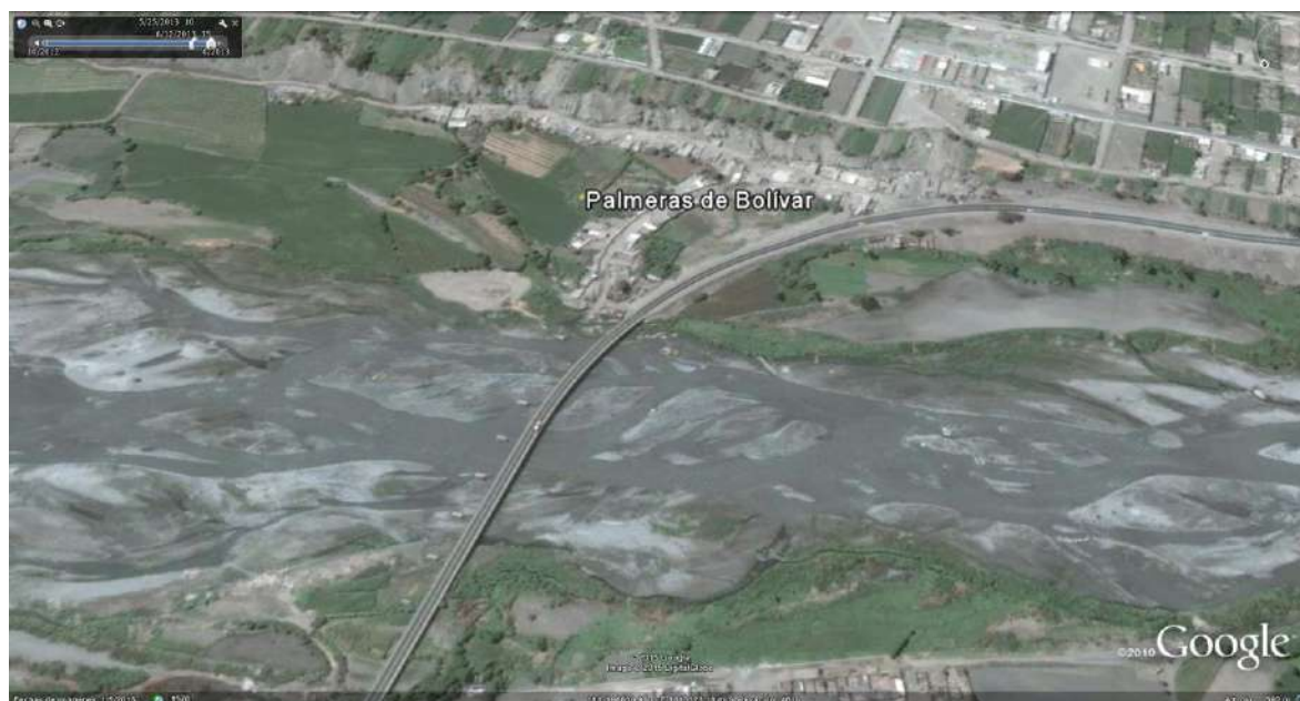
Figura 4. Vista del sector Palmeras de Bolívar ubicado sobre un dique del puente antiguo (Barranca).
