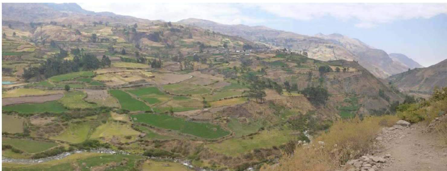
Foto 11. Deslizamientos en el sector Canta, margen izquierda del río Chillón (Canta).
