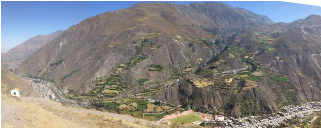
Foto 21. Deslizamiento en el sector Payhua. Al pie del depósito es afectado por erosión de laderas y derrumbes que pueden afectar viviendas y estadio de Matucana.
