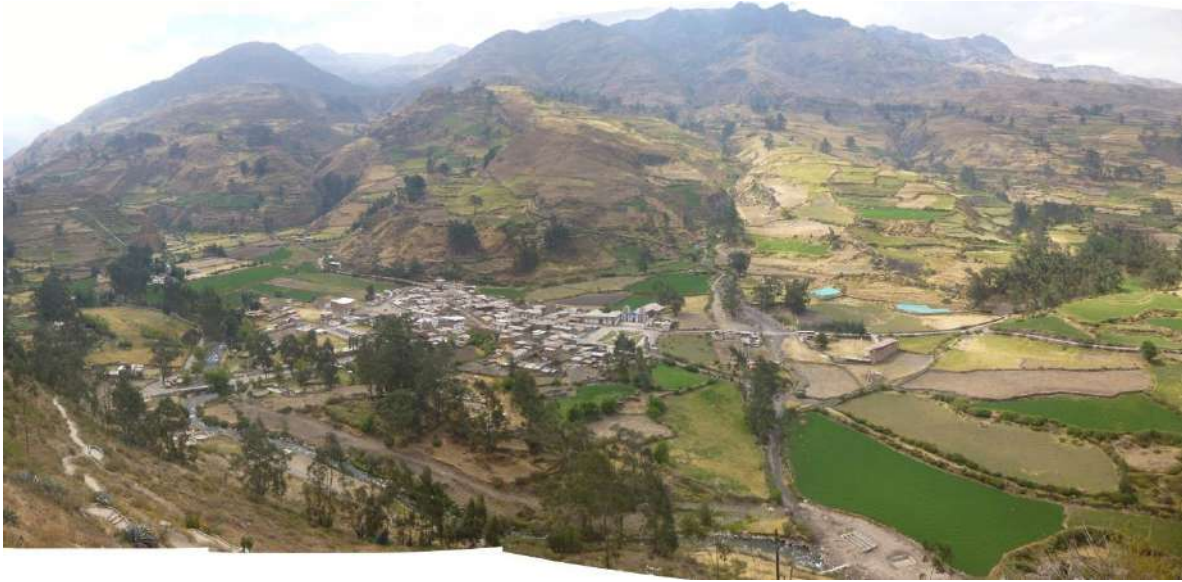
Foto 12. Flujos de detritos en la margen izquierda del río Chillón, km 2+140 de la carretera Canta-Obrejillo, sector Obrejillo (Canta).
