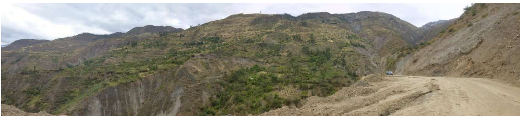
Foto 9. Vista panorámica del sector Llocchi, distrito de Huancapón (Cajatambo), el poblado se encuentra sobre el cuerpo de un deslizamiento reactivado a manera de derrumbes y erosión de laderas, en ambas márgenes de la quebrada Tumac.
