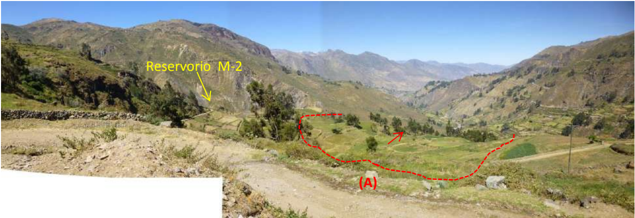
Foto 18. Vista panorámica que evidencia la intensa actividad geodinámica en el sector Pampas, (A) Escarpa de una reactivación de deslizamiento rotacional en la margen izquierda del río Mala.
