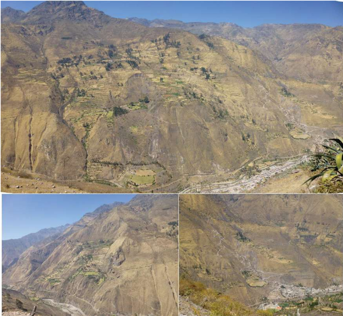
Foto 22. Deslizamientos en margen izquierda del río Rímac, y flujo de detritos antiguos donde hoy se ha asentado el poblado de Matucana. Con derrumbes de ambos márgenes. De producirse lluvias excepcionales afectaría enormemente a la ciudad.
