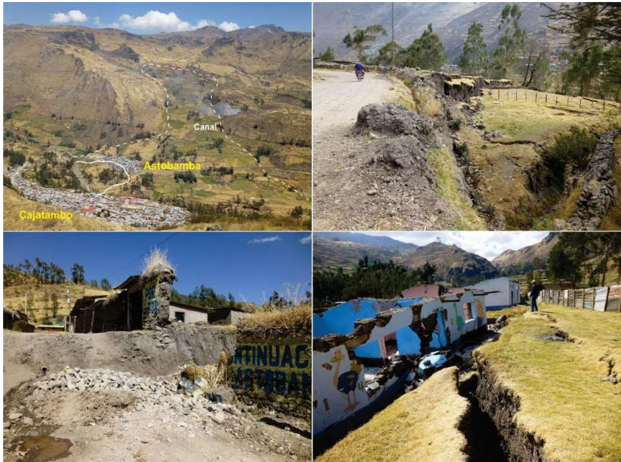
Foto 10. Imágenes del deslizamiento de Astobamba (Cajatambo) tomado el 24 de agosto del 2012.
