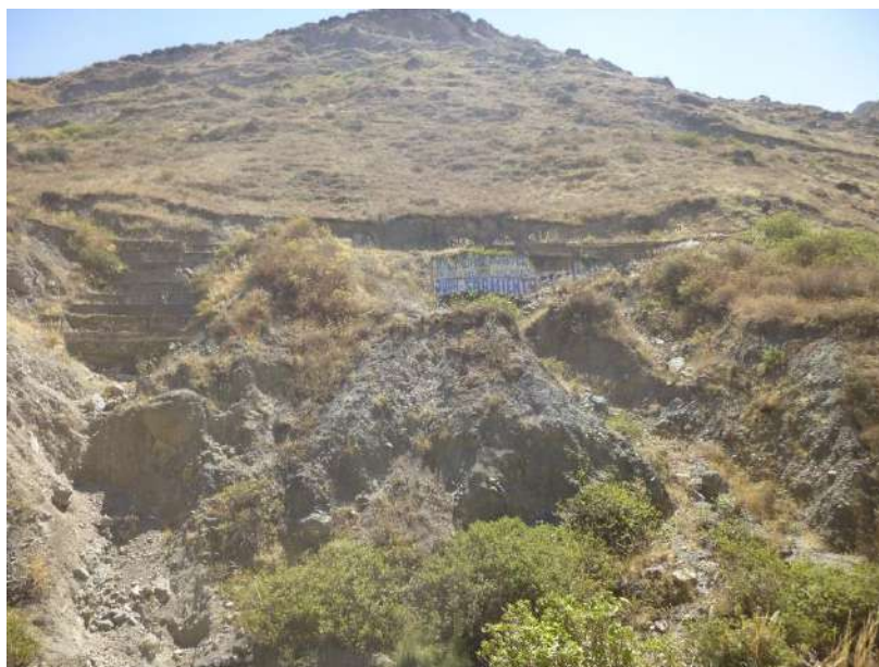
Foto 14. Deslizamiento en la margen derecha del río Chancay, Sector Baños
