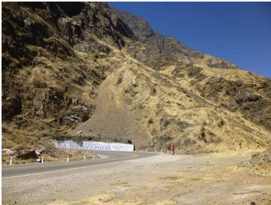
Foto 2. Derrumbes que afectan a la carretera central por lo que han hecho muro de concreto y sobre él muro con gaviones para evitar que caigan y ocasionen un accidente.
