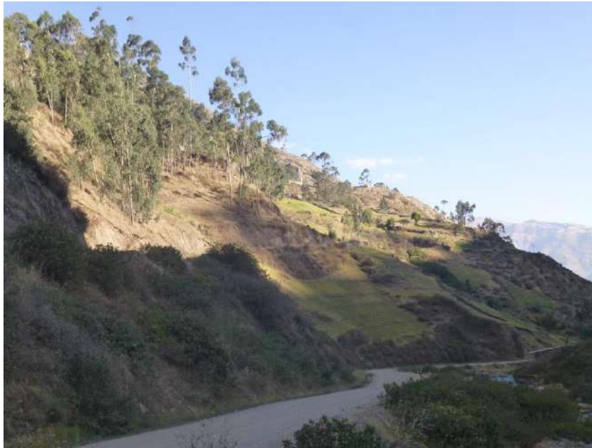
Foto 16. Deslizamiento en margen izquierda del río Chancay, Sector Santa Catalina
