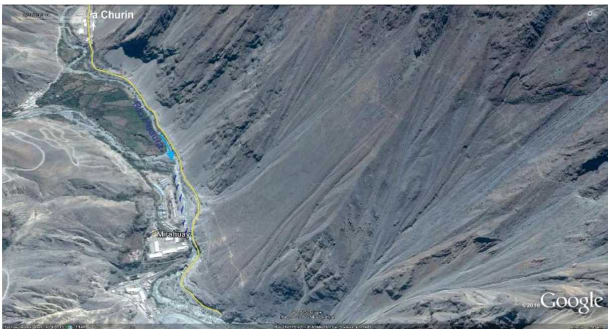
Figura 7. Erosión fluvial en la margen derecha del río Huaura y derrumbes en forma de canchales de detritos en el cerro Antaycoto, talud superior de carretera Huaura-Churin en la margen izquierda de río Huaura, en el sector Mirahuay.
