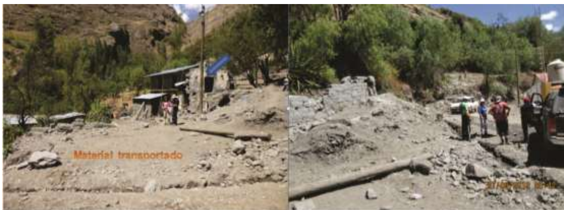
Fotos 12 y 13. El flujo de Paccayura (distrito de Progreso, provincia de Grau) impactó con varias viviendas ubicadas en su cauce.
