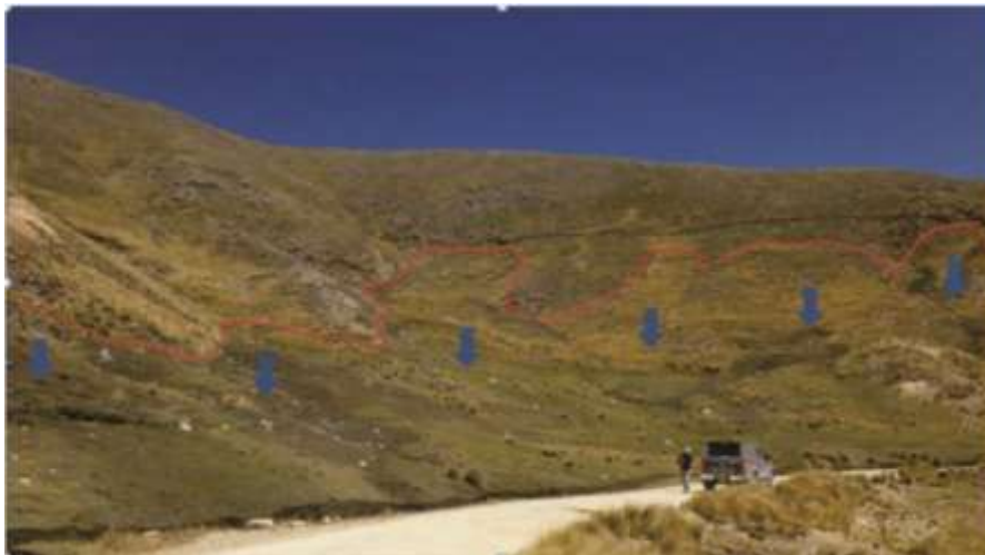
Foto 21. Reptación del sector de Sabaino en la provincia de Antabamba. La flecha azul señala la dirección de desplazamiento.
