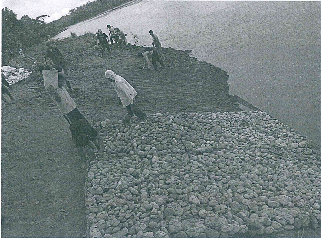
Colocación provisional de roca con la finalidad de controlar la erosión
