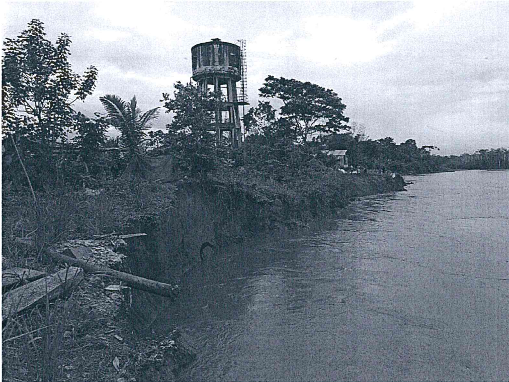
Tanque de agua en peligro debido al avance de la erosión
