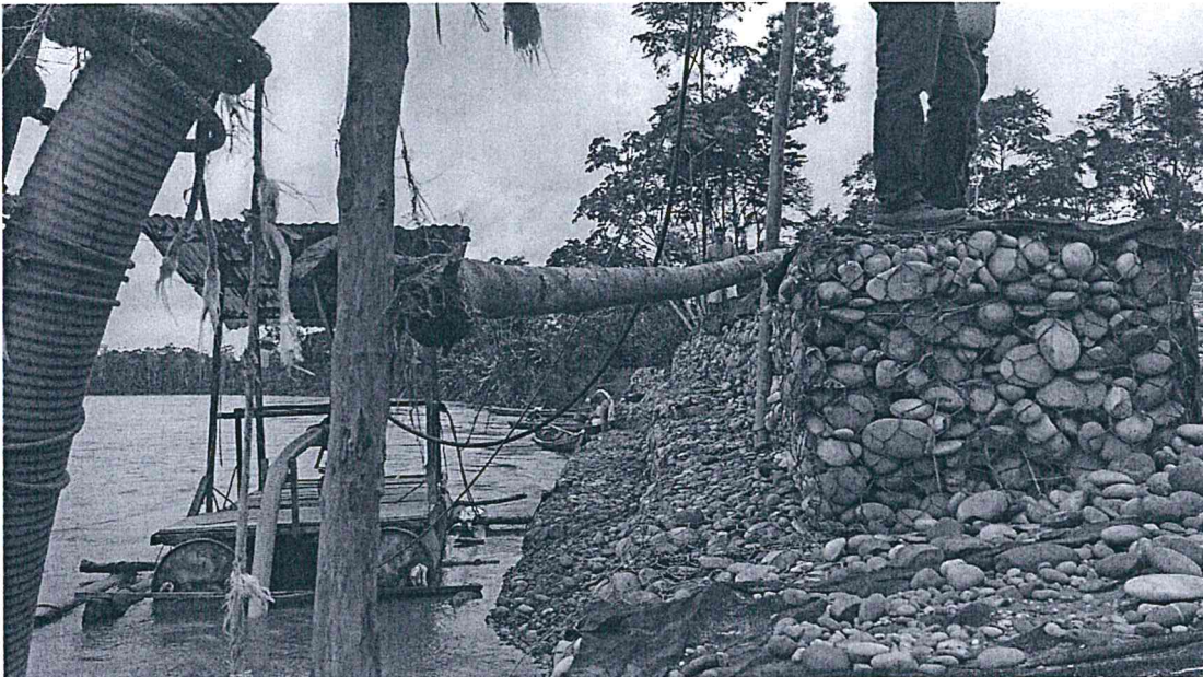
Zona de captación de agua
