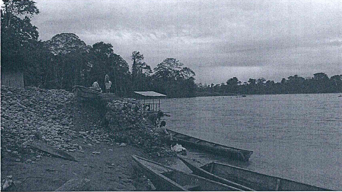
Colocación de gaviones en la zona de captación de agua
