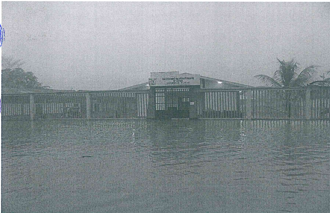
Vista de la Institución Educativa Primaria completamente Inundada
