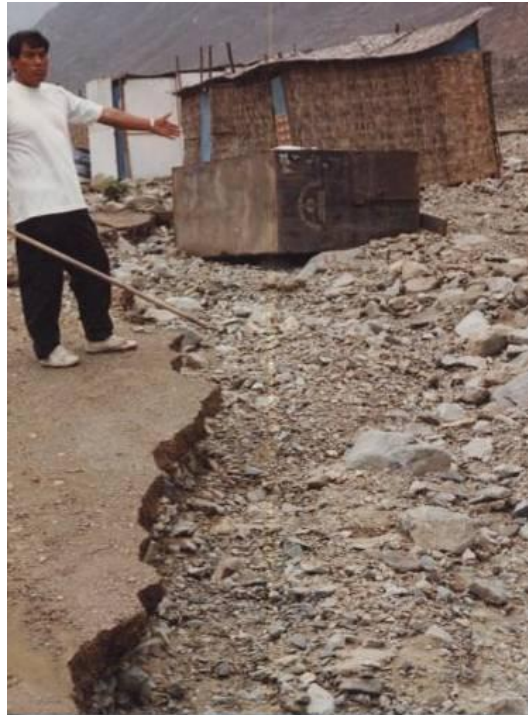
Foto 9. Materiales acarreados por los huaycos en la quebrada Media Luna (Fuente. Comunidad Campesina Jicamarca, 2002).
