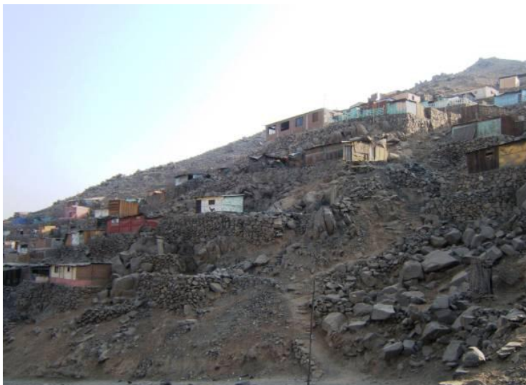
Foto 7. Zona predispuesta a las caídas de rocas debido a la construcción inadecuada de viviendas sobre pircas. A.H. Nuevo Amanecer. (Fuente. INGEMMET 2009)
