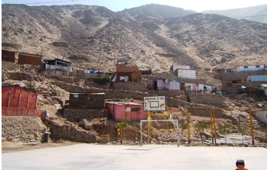
Foto 7. Zona de depósitos de piedemonte, propensa a caídas de rocas. Asentamiento Humano Nueva Jerusalén. Fuente: INGEMMET, 2009
