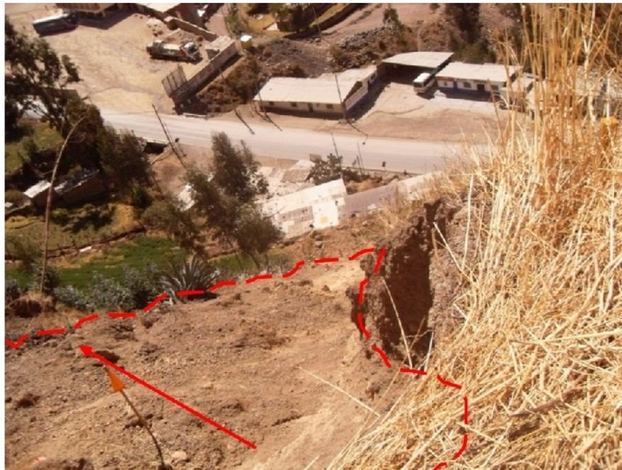
Figura 17: Vista del deslizamiento (D-2) ubicado en el extremo norte de la Quebrada Chahuatupe, donde se asientan viviendas contiguas a la Carretera Central (Figura 15)
