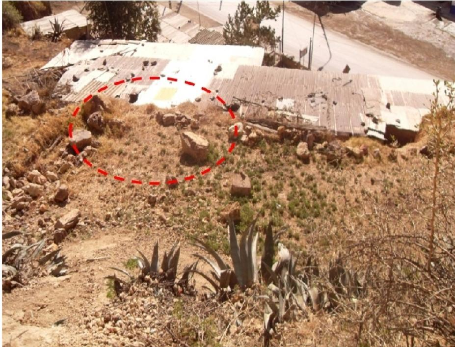
Figura 19: Desprendimiento de rocas que afectan a las viviendas ubicadas en el extremo Norte de la quebrada Chahuatupe (Figura 15)
