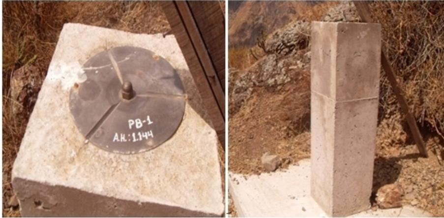
Figura 28: Hito estación base PB-1 ubicado en la zona geotécnica sur.
