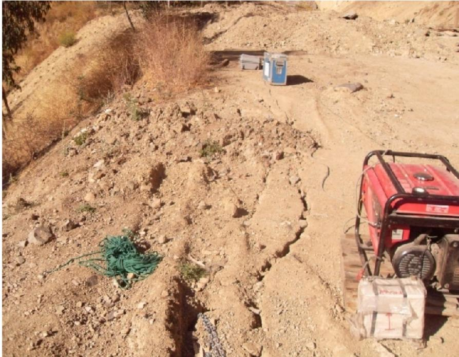
Figura 14: Agrietamientos paralelos a la orientación del canal de aducción que afectan al suelo arenoso limoso, sector el badén en la cota 3145 m.s.n.m. (Figura 9)
