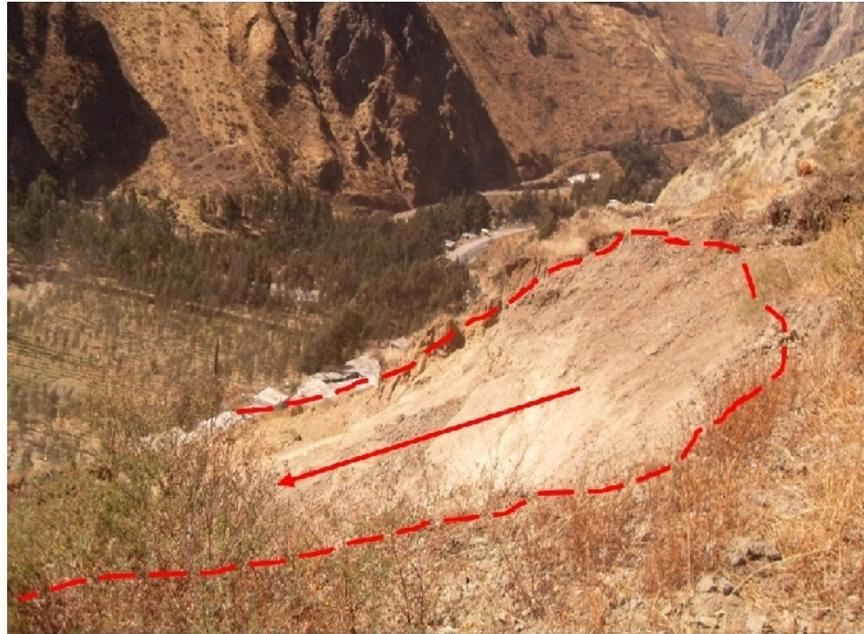
Figura 16: Vista desde la parte alta del deslizamiento (D-1) producido el 16 de agosto del 2011, que afecta el talud hasta la Carretera Central (Figura 15)
