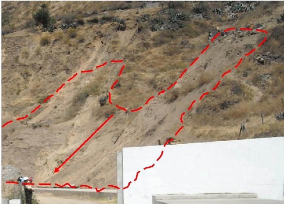
Figura 21: Deslizamiento (D-4) ocurrido en el extremo Norte del canal de aducción, donde se hicieron trabajos de estabilización de la ladera (Figura 15)
