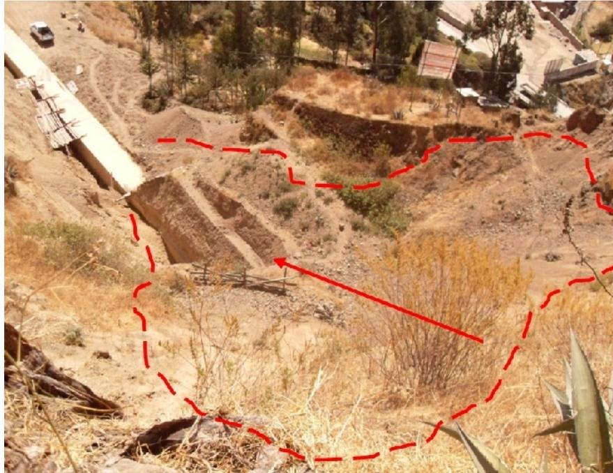
Figura 20: Deslizamiento (D-3) que afecta al canal de aducción, se localiza en la parte alta de la portada del túnel (Figura 15)
