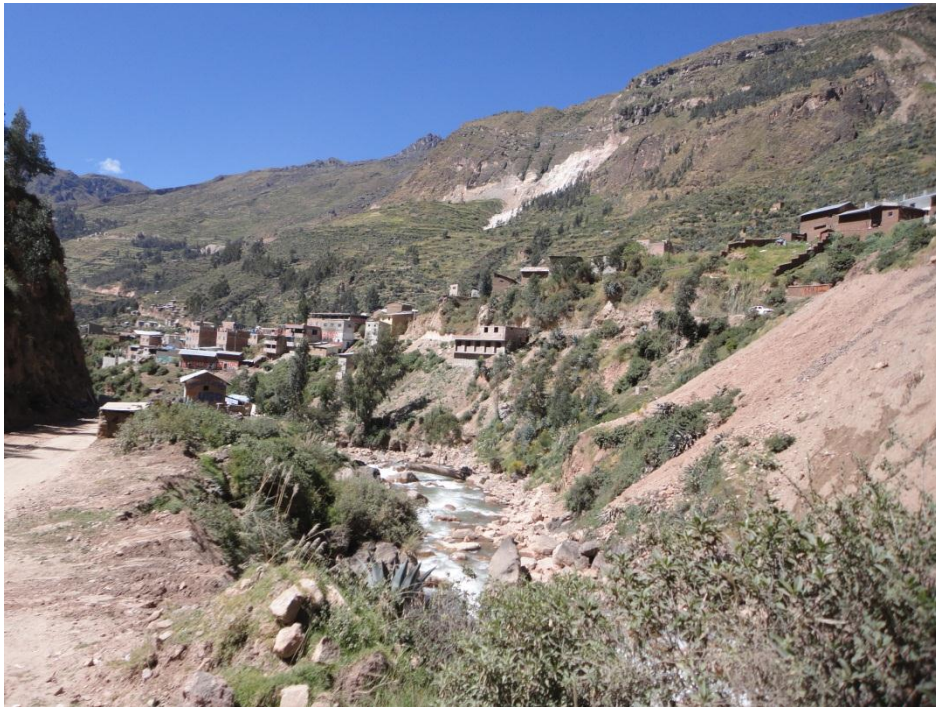
Foto 18: Derrumbes en el sector Yanahuanca, el poblado se encuentra en un depósito antiguo, con reactivaciones en el pie, margen derecha del río Yanahuanca.
