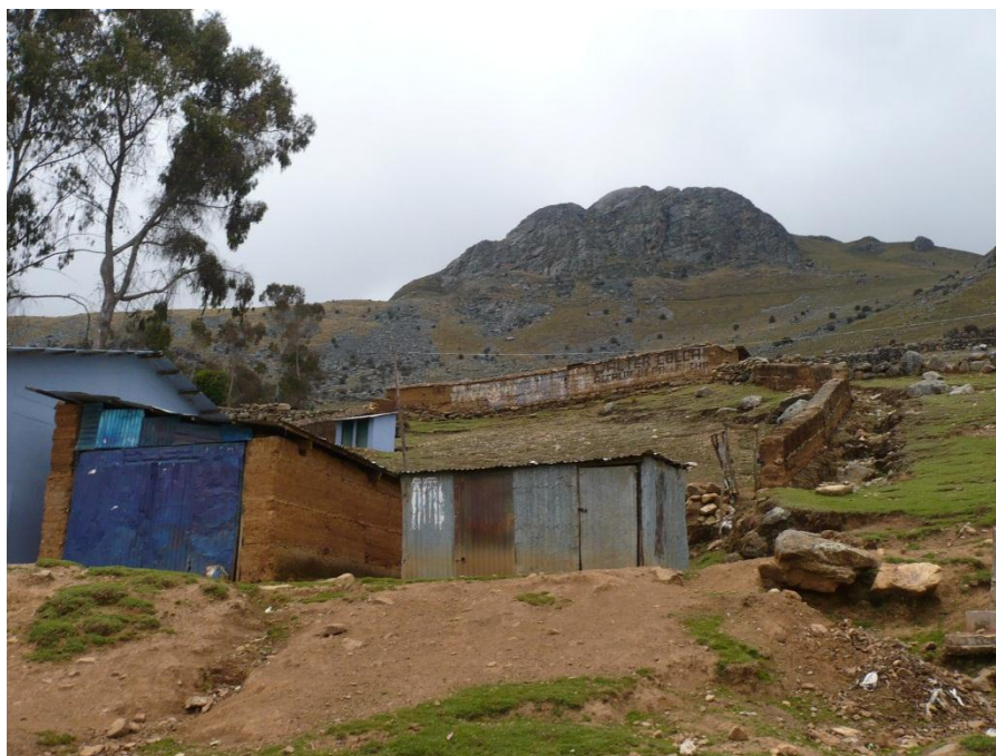
Foto 11: Caída de rocas en cerro Argoaro, canchales de detritos suspendidos en ladera, puede afectar a las viviendas del sector Chunquipata.
