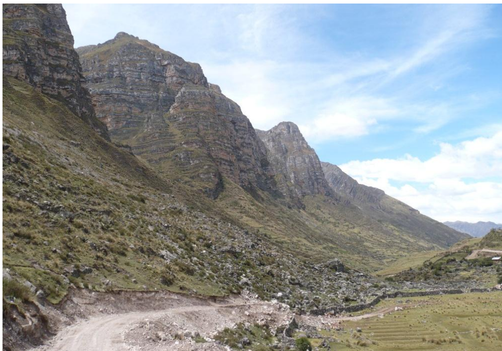
Foto 15: Derrumbes en talud superior de carretera nueva Yanahuanca-Pampamarca con proyección hasta Ucchu Chacua, con presencia de canchales de detritos, margen izquierda del río San Juan Valle Rabi
