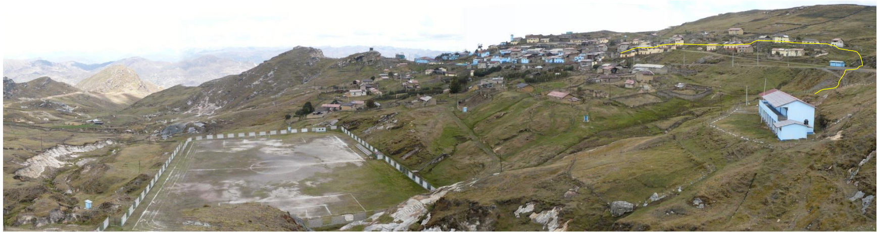
Foto 05: Vista panorámica del poblado Goyllarisquizga, parte de la población se encuentra sobre un deslizamiento rotacional antiguo con reactivaciones en forma de flujo de tierra, presenta asentamientos.
