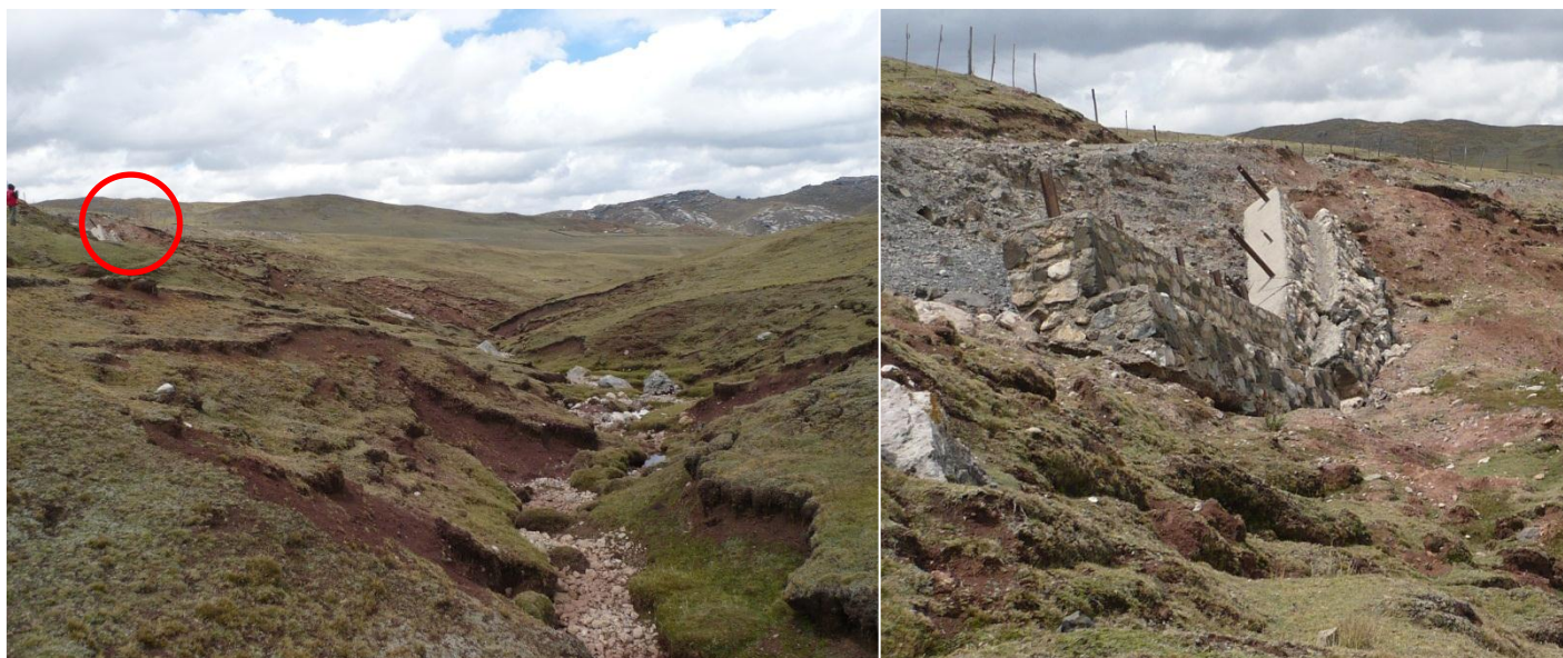
Foto 12: Reptación de suelos en quebrada tributaria, de la margen derecha del río Pacobamba, en el detalle de la derecha se puede observar el colapso de un muro de contención de aprox. 8 m de longitud y alcantarilla que se encontraba en la plataforma inferior de la carretera Pasco-Goyllarisquizga.
