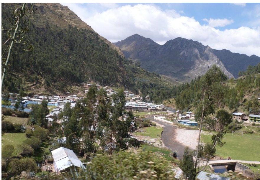
Foto 16: Zona de probable inundación fluvial en ambas márgenes del Río San Juan Baños Valle de Rabi a la altura del Km. 2+120. Con presencia de lluvias excepcionales, se ha desbordado hasta 50 m en la margen derecha del río, afectando a viviendas del poblado Pampamarca. Se ha colocado muro de contención.
