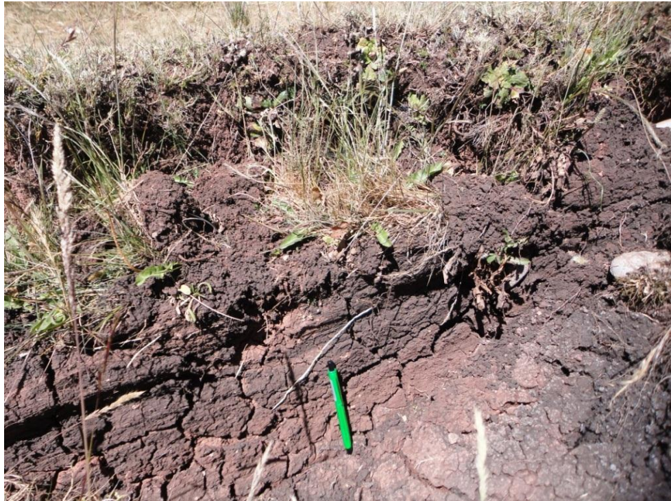
Foto 27: Vista de la superficie de corte por donde se desplazó el flujo producto del deslizamiento.
