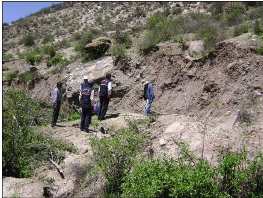
Figura 7: Escarpe principal del deslizamiento de Amata 1.
