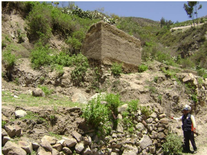
Figura 9: Grietas tensionales ocasionadas en el deslizamiento Amata 2.
