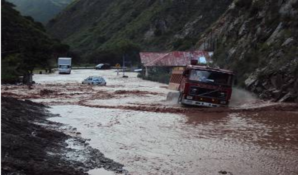
Figura 12: Se observa la enorme dificultad con la que los vehículos tratan de sortear el desborde del río Colorado. Tomada del registro fotográfico de la Municipalidad de Limatambo.
