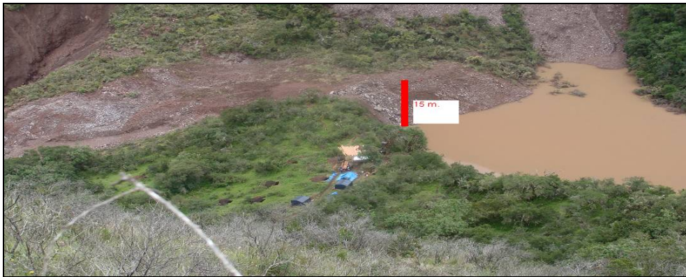
Figura 18: En esta imagen se puede apreciar la distancia entre el espejo de agua y la altura máxima del dique natural. Tomada del registro fotográfico de la Municipalidad de Limatambo.
