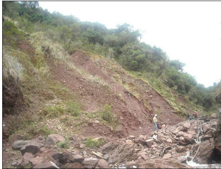
Figura 27: Reactivaciones en la base de antiguos deslizamientos en la parte media de la quebrada Samas debido al socavamiento causado por el río.
