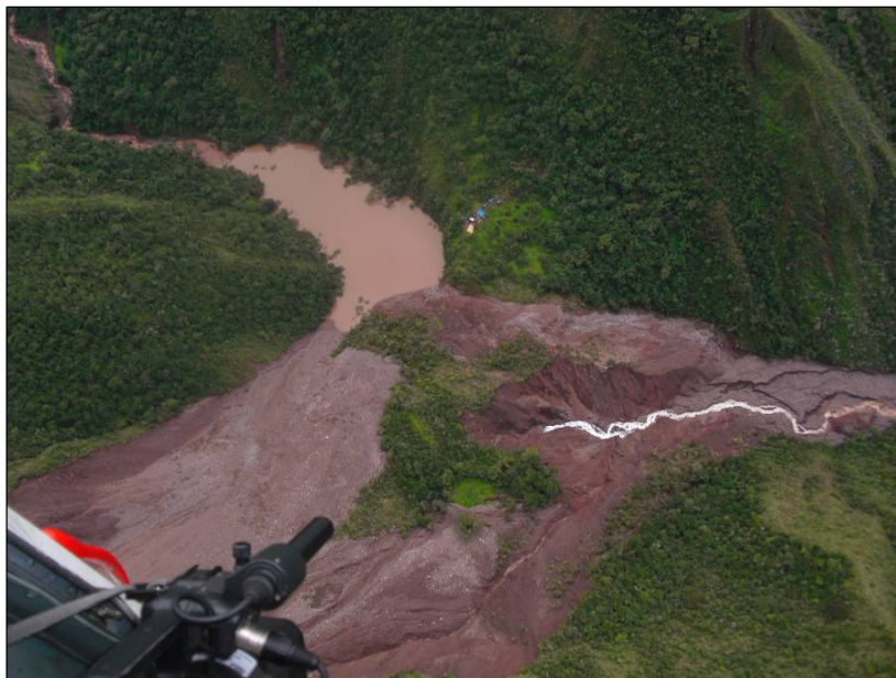
Figura 9: Vista aérea de la zona de ruptura del dique natural (por filtraciones), que generó el aluvión del 25 de enero de 2010. Tomada del registro fotográfico de la Municipalidad de Limatambo.
