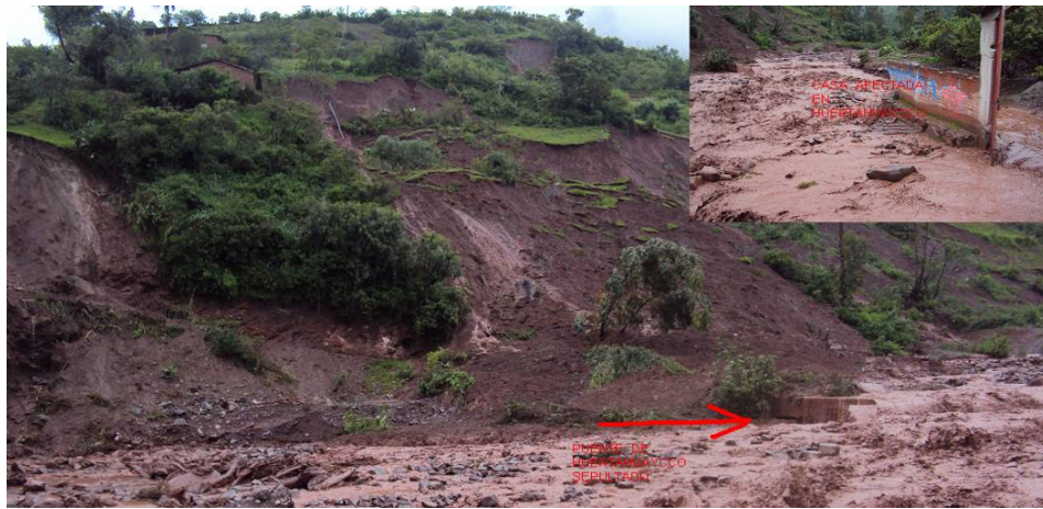
Figura 10: Río Colorado, en la fotografía se observa la reactivación de deslizamientos y el puente Huertahuycco destruido. Tomada del registro fotográfico de la Municipalidad de Limatambo.
