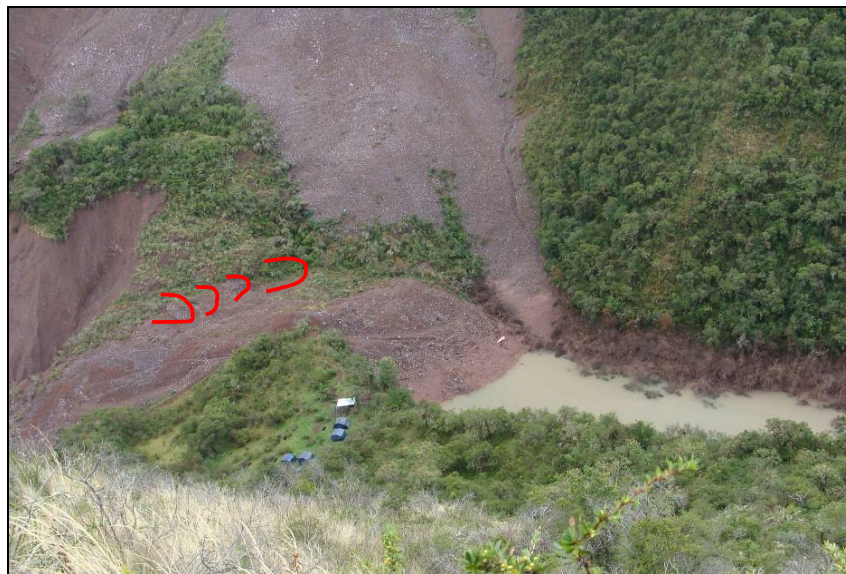
Figura 21: Las líneas rojas indican la zona de hundimiento del dique natural en forma retrogresiva por efectos de la tubificación.
