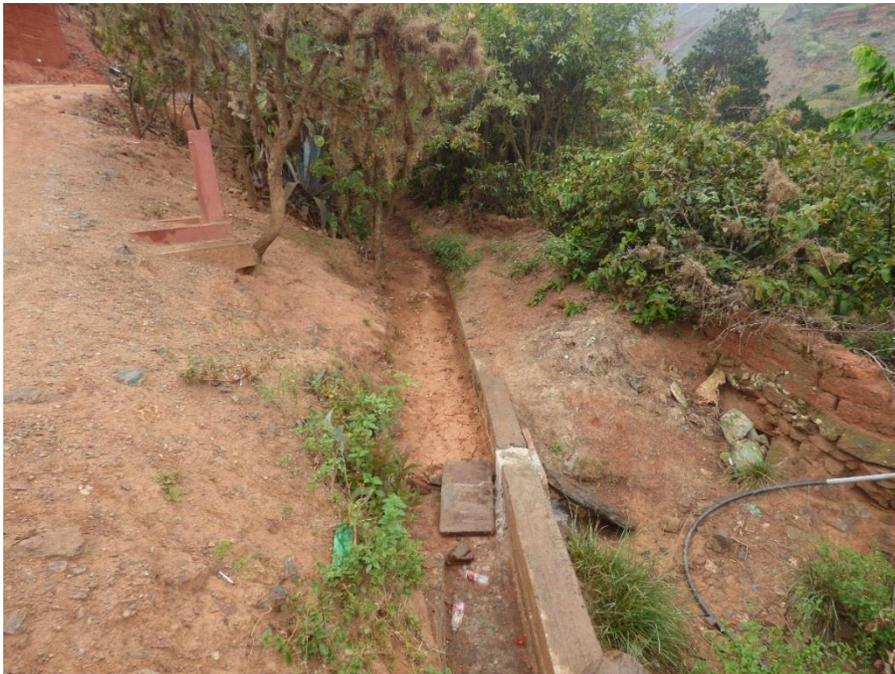
*Foto 14. Canal de regadío, con revestimiento defectuoso.*
