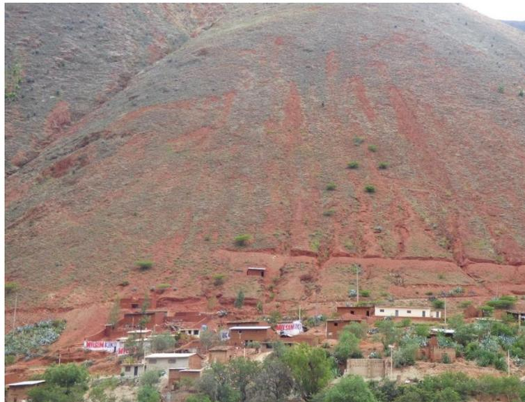
Foto 11. Procesos de erosiones de ladera que generan flujos de detritos o lodo, de activarse afectarían las viviendas ubicadas en la parte baja de la ladera y vía de acceso. Sector de Piscupata.
