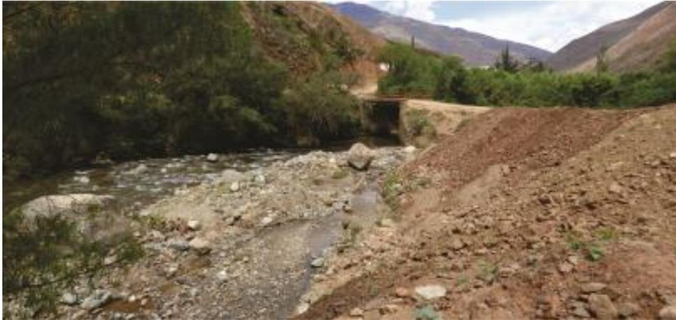
Foto 16. Margen derecha del río Quera, rellena con desmonte.
