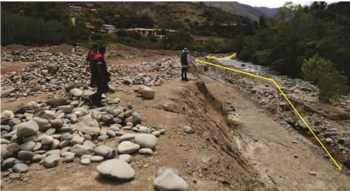
Foto 17. Margen derecha del río Quera. Se aprecia la defensa ribereña (línea amarilla). Sobre ella se está rellanando con desmonte. Esta zona no debe ser ocupada, debe ser declarada intangible.
