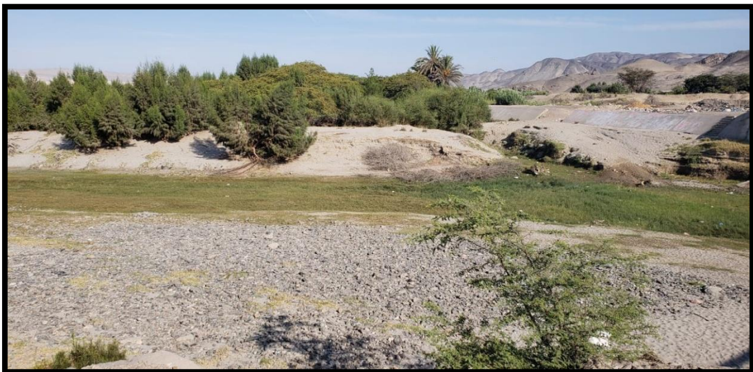
Margen derecha de rio Ica, aguas abajo, en el sector de Puente Ocucaje, se aprecia la erosión ocasionada por el caudal del rio en los meses de avenida del agua.
