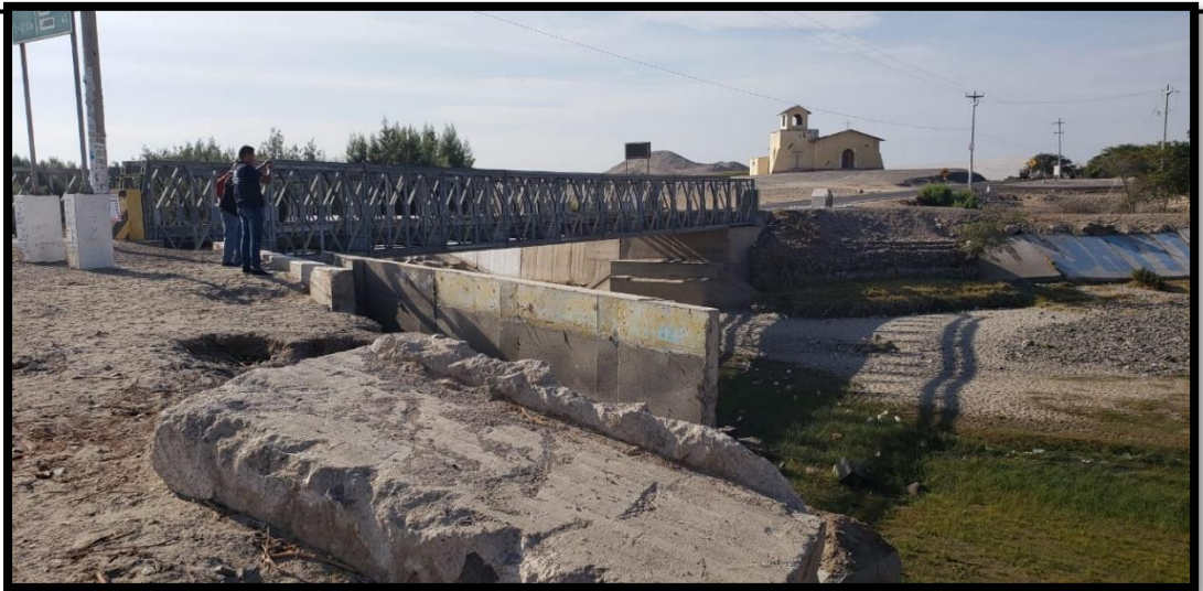
Puente Ocucaje, el cual es el único medio de interconexión a el 50% de la población de Ocucaje, así mismo es medio por el cual pasan la tubería para abastecer de agua potable a la población.
