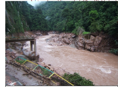
25.-Puente que comunicaba el Boqueron del Padre Abad con el sector de Velo de Novia, destruido, note la baranda de protección del camino peatonal destruido, y los restos de troncos de árboles.
