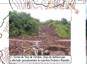
2.- Sector de Tres de Octubre, flujo de detritos que ha afectado parcialmente la carretera Federico Basadre.
