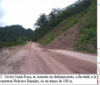
5.- Sector Santa Rosa, se muestra un deslizamiento, afectado a la carretera Federico Basadre, en un tramo de 100 m.
