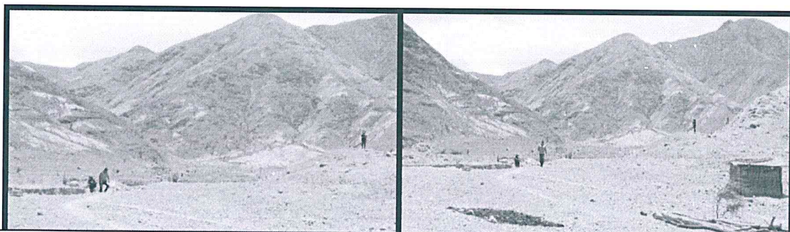
Actualmente la quebrada Chantay no se encuentra en buenas condiciones
