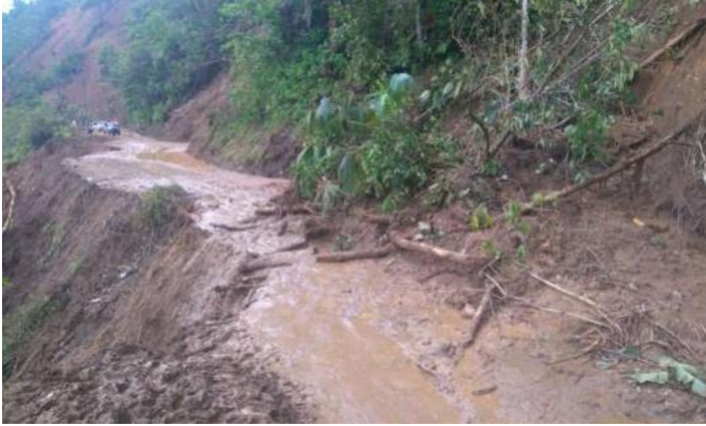
Foto 11: Carretera antigua Satipo-Huancayo obstruido por la ocurrencia de derrumbes. Fuente INDECI-COEN, 2016.
