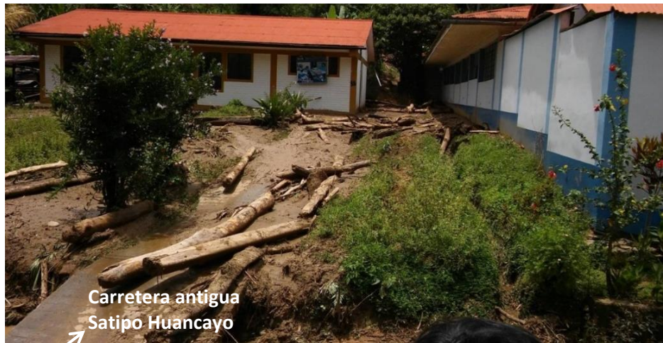
Figura 7: Troncos de árboles transportados por el flujo de lodo, llegaron hasta la carretera antigua Satipo-Huancayo. Fuente COEN – INDECI 2016.
