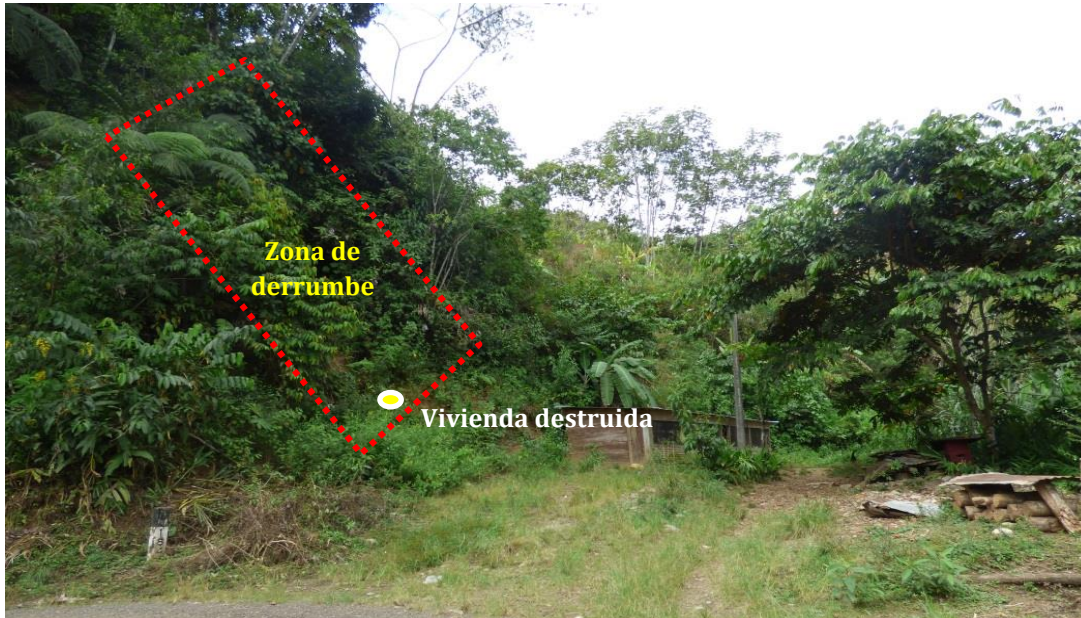
Figura 15: Zona de derrumbe.
