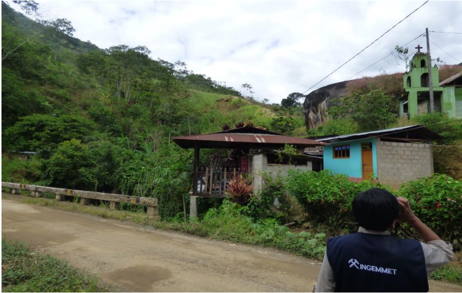
Foto 2: Vista de viviendas asentadas sobre el pie de monte.
