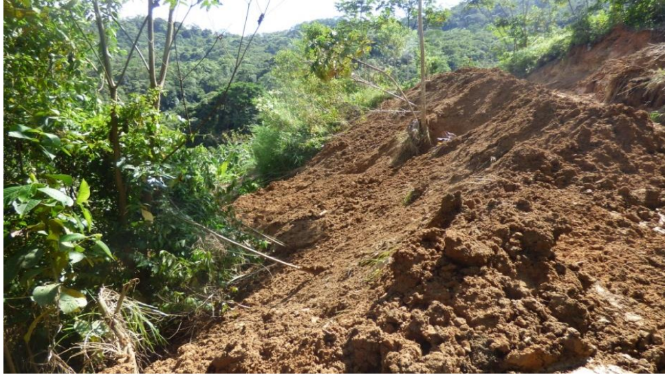
Foto 14: Material vertido sobre laderas muy empinadas.
