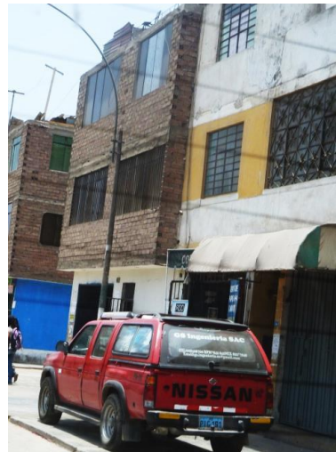
Figura 26. Edificaciones de mampostería de tres niveles. Uso compartido: vivienda-comercio. Manzana 902.
