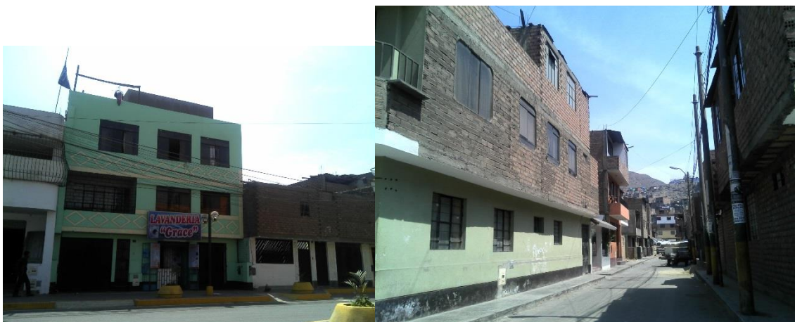
Figura 32. Edificaciones de albañilería con unidades tubulares de dos y tres niveles
