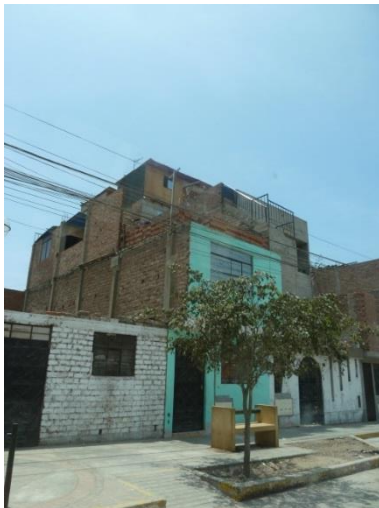
Figura 25. Edificaciones de mampostería de 03 niveles. Se observa que sobre el nivel superior se ha construido una ampliación provisional de madera. Manzana 678.
