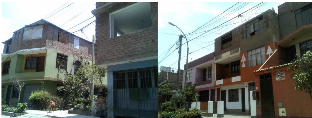
Figura 29. Edificaciones características del Sector 06
