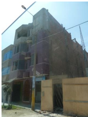
Figura 35. Edificación de cuatro niveles; uso: vivienda-comercio. Manzana: 1301.
