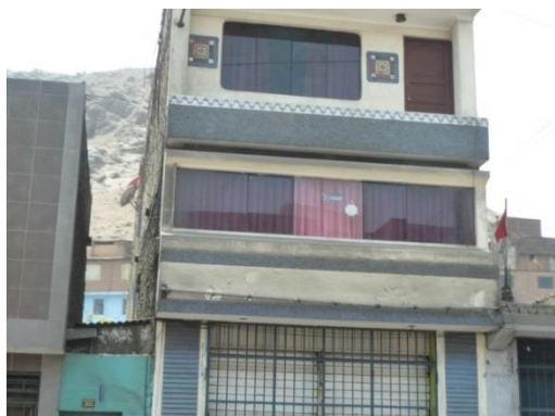
Figura 21. Edificaciones de mampostería de tres niveles, en buen estado de conservación. Uso: vivienda-comercio. Manzana: 798.
