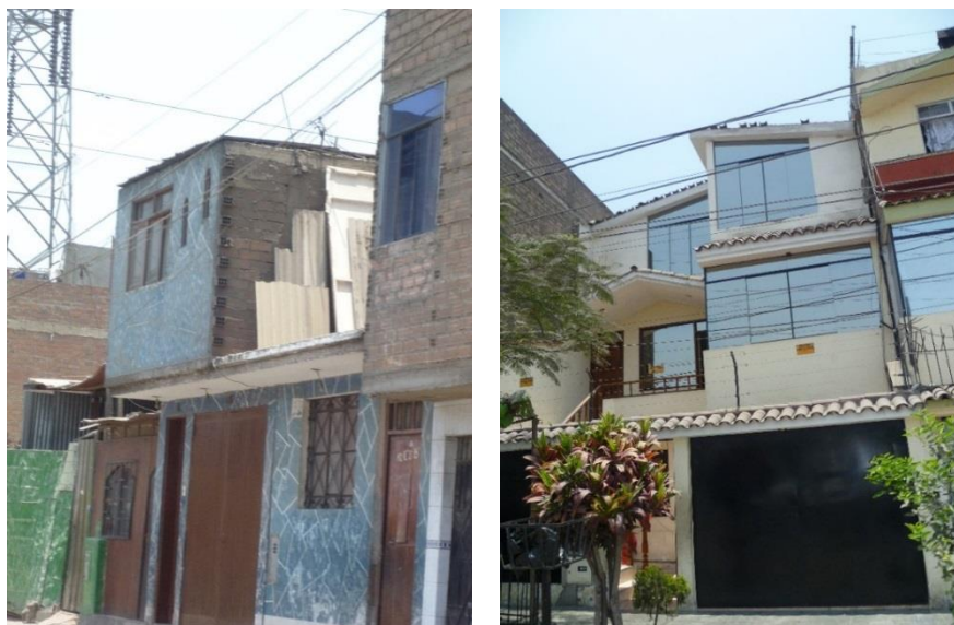
Figura 30. Edificaciones de albañilería tarrajeadas parcial y/o totalmente
