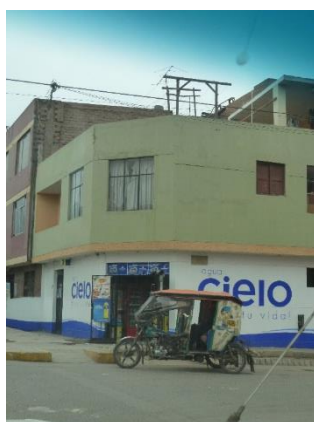
Figura 13. Zona comercial del Sector 01.
