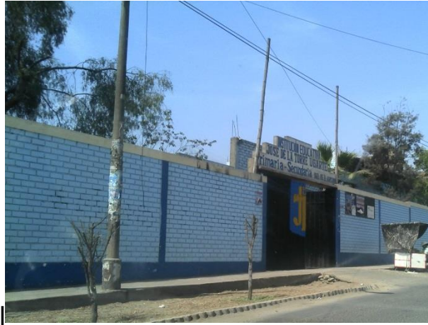
Figura 69. Centro educativo José de la Torre Ugarte de 2 niveles con presencia de columna corta.
