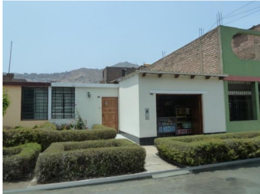
Figura 23. Edificaciones de mampostería de un nivel, en buen estado de conservación. Uso: vivienda. Manzana: 752.
