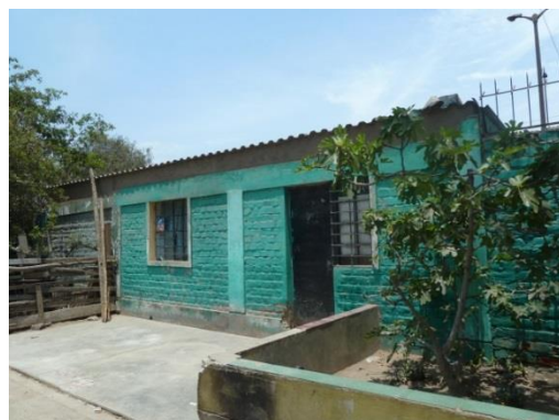
Figura 27. Edificaciones de un nivel. Uso: vivienda. Manzana 156.
