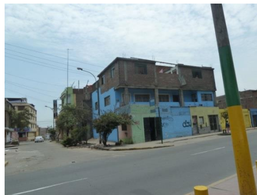
Figura 20. Edificación de tres niveles. Se aprecia que la construcción original sufrió una ampliación. Manzana 343.
