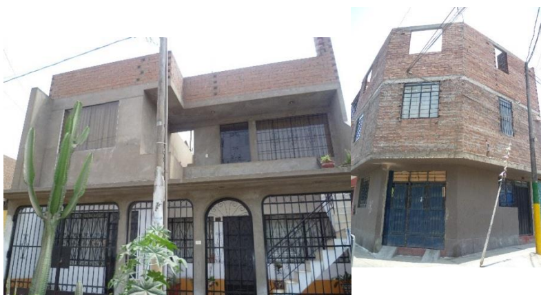
Figura 33. Edificaciones de viviendas del Sector 08, de dos y tres pisos.
