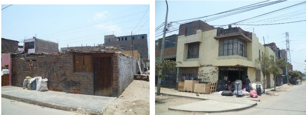
Figura 31. Edificaciones con irregularidad estructural
