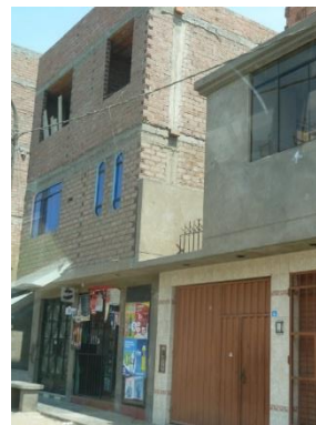
Figura 36. Edificaciones de mampostería de tres niveles. Uso: vivienda-comercio. Manzana 53.
