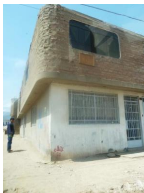
Figura 37. Edificaciones de dos niveles. Manzana 514. Regular estado de conservación.
