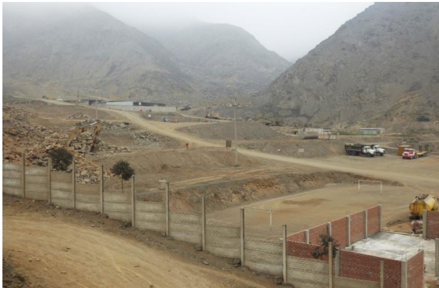
Foto 15: La extracción de agregados (cantera), deja material suelto en el cauce antiguo de la quebrada Progreso, de reactivarse todo el material sería movido cuesta abajo, afectando nuevamente al asentamiento humano.
