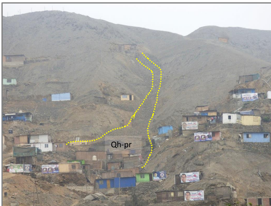
Foto 5: Depósito proluvial. Se observan viviendas ubicadas en el cauce de la quebrada Los Solidarios aparentemente seca.
