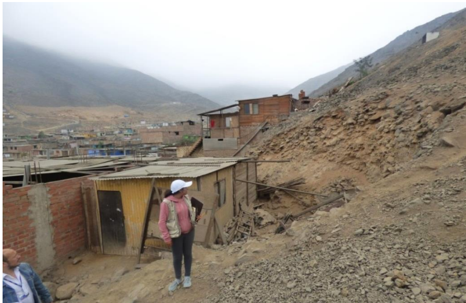
Foto 13: Ladera inestable por corte de talud para la construcción de vivienda.
