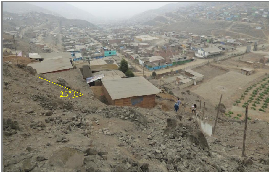
Foto 7: Depósito coluvial, se observa bloques sueltos en ladera moderadamente empinada.
