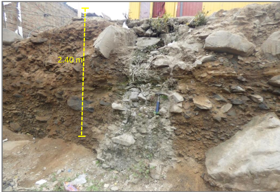
Foto 5: Depósito proluvial, con bloques de hasta 50 cm de diámetro. El corte de talud muestra su composición. Se observan viviendas ubicadas sobre este tipo de depósito.
