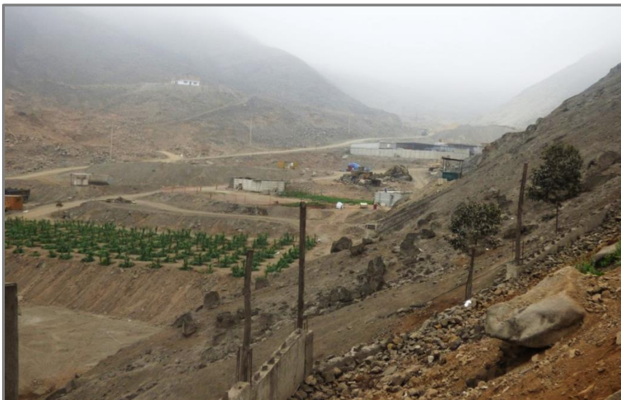
Foto 12: Caída de rocas en ladera empinada
