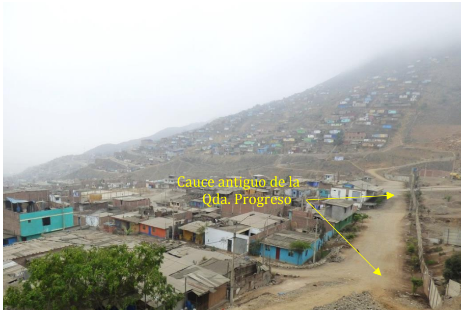
Foto 1: Vista de viviendas ubicadas sobre un abanico proluvial.
