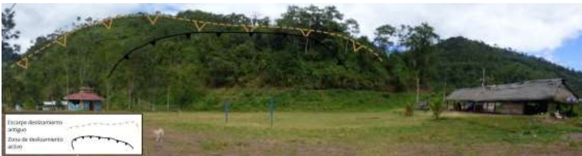
Figura 11. Deslizamientos en el talud carretero de la zona del colegio primary de Pitocuna.
