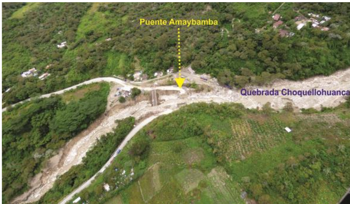
Figura 18. Se muestra el recorrido del flujo de detritos, sector Puente Amaybamba.
