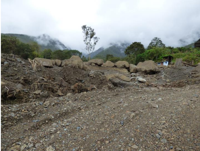
Figura 10. El flujo llegó a superar la defensa ribereña, sector de Pedregal.
