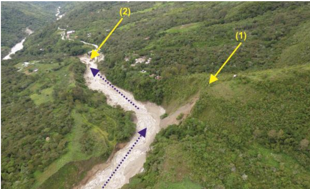
Figura 20. Se muestra: (1) derrumbe originado por la erosión del flujo de detritos en la margen derecha. (2), Puente Amaybamba destruido. Se aprecia también los cambios de dirección que ha tenido el flujo durante su recorrido.
