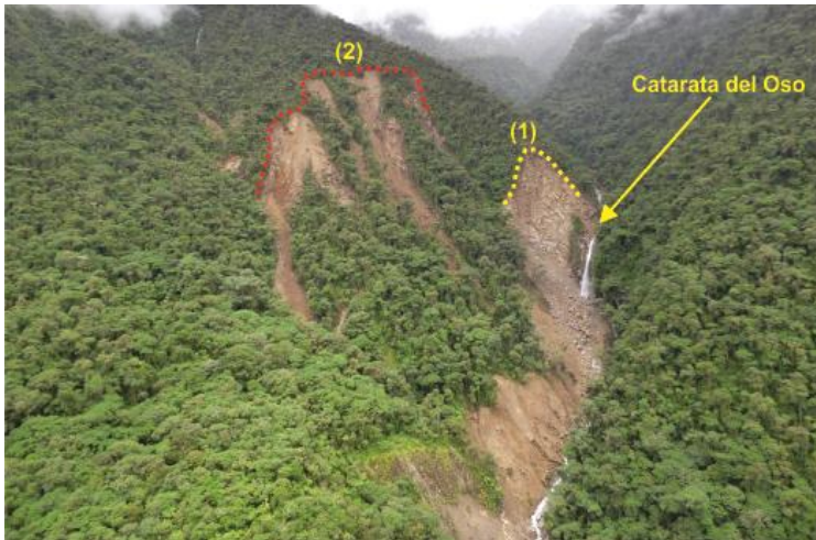
Figura 16. (1) Derrumbe cerca de la catarata del Oso. (2) Deslizamiento ubicado en la margen derecha, parte media de la quebrada Sicra. Considerada como zona inestable.
