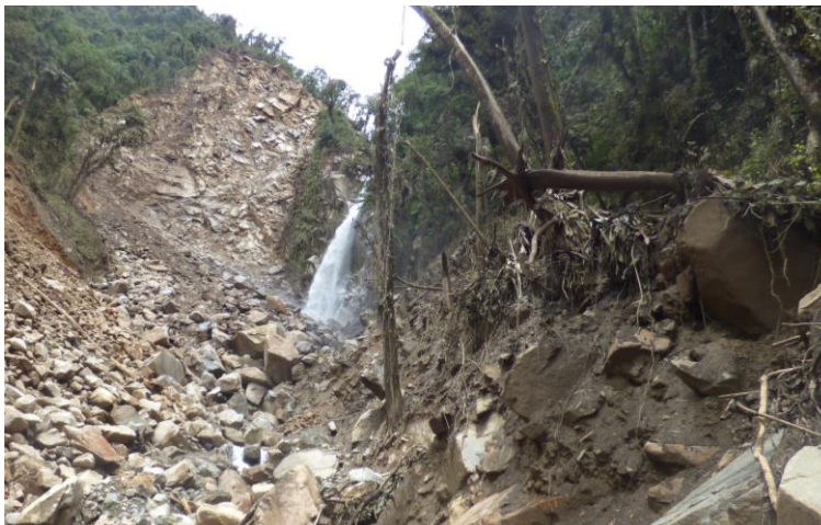
Figura 12, catarata del Oso, se aprecia los derrumbes en la margen derecha.
