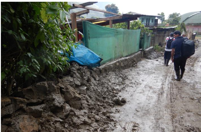
Figura 11. Viviendas afectadas por el flujo de lodo. Sector Sicre
