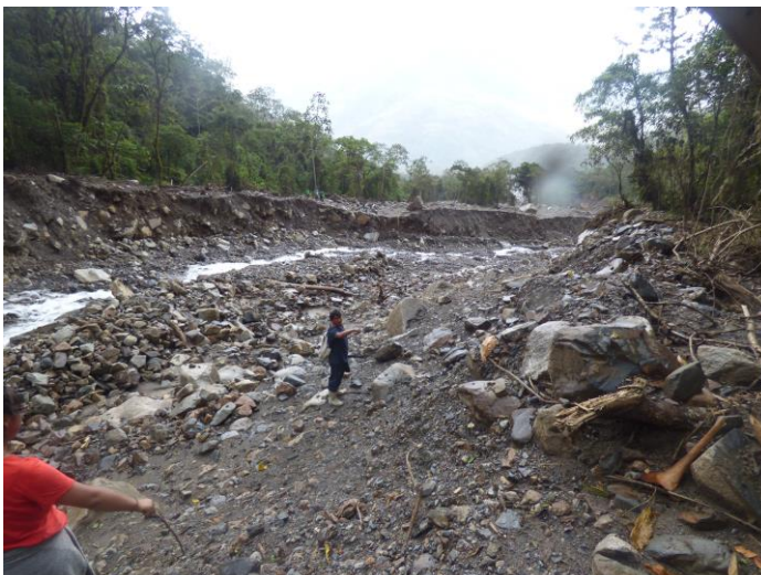
Figura 9. Socavamiento de la quebrada, llegó hasta 4 m.
