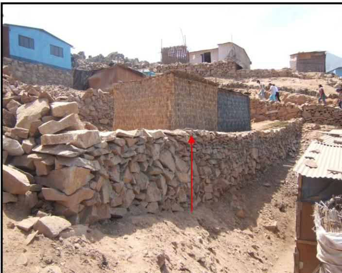
Foto 5.- En la Manzana H, Lote 7, se observó una pirca con altura hasta 1.80 m. La pirca esta hecha en base de bloques, con tamaños predominante entre 20-30 cm, llegan hasta 80 cm.
