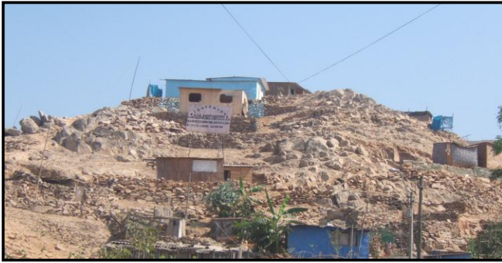
Foto 1.- Entrada al asentamiento humano Hijos del Jirón Callao. Se aprecia que esta asentado sobre una colina.
