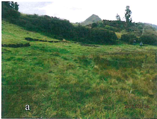
Foto 8. Vista viendo hacia el noreste, donde se observa parte de la corona del deslizamiento rotacional en el sector de Unuhuanay con saltos verticales hasta 0.60 m (a), abertura entre 0.10 a 0.20 m con nivel freático a 0.10 m de la superficie (b).
