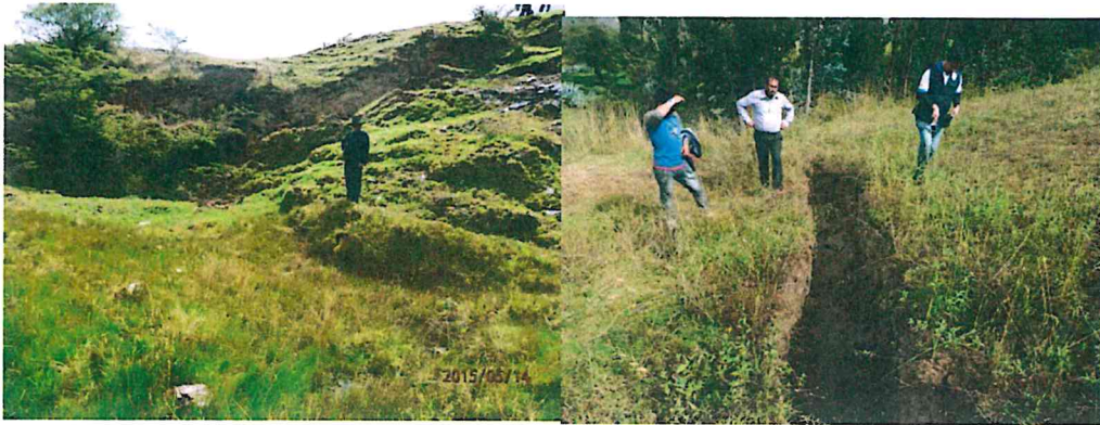
Foto 7. Vista viendo hacia el suroeste, donde se observa parte de la corona en el sector de Almapampa con salto vertical de 1.5 m
