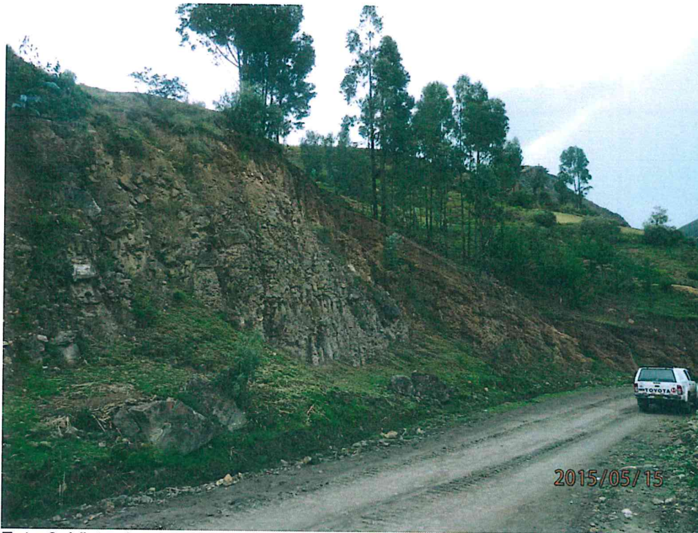
Foto 6: Vista donde se aprecia los depósitos coluviales – proluviales, formados por arcillas, arenas con gravas, guijarros y en menor proporción cantos gruesos angulosos a sub angulosos. Se observa en el km 29+480 carretera a Piscobamba sector Cauchos.
