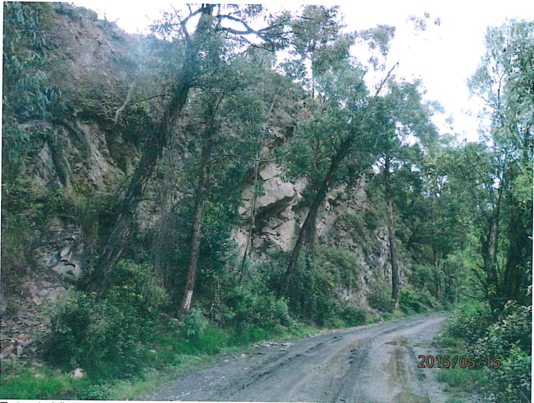
Foto 4: Vista donde se aprecia el afloramiento de las areniscas con dirección de buzamiento noroeste, en el km 24+040 carretera a Piscobamba
