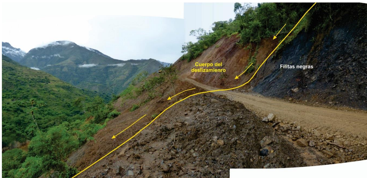
Foto 6: Vista en la cual se marcó con línea color amarillo la superficie de falla en el flanco izquierdo del deslizamiento, es posible observar también las filitas de color negro que sirvieron como zona de despegue de este deslizamiento.
