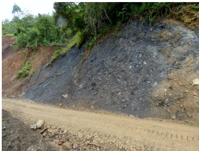
Foto 2: Vista en la que se puede ver el grado de fracturamiento en los niveles de filitas oscuras, muy fracturadas que forman parte de un depósito coluvial.
