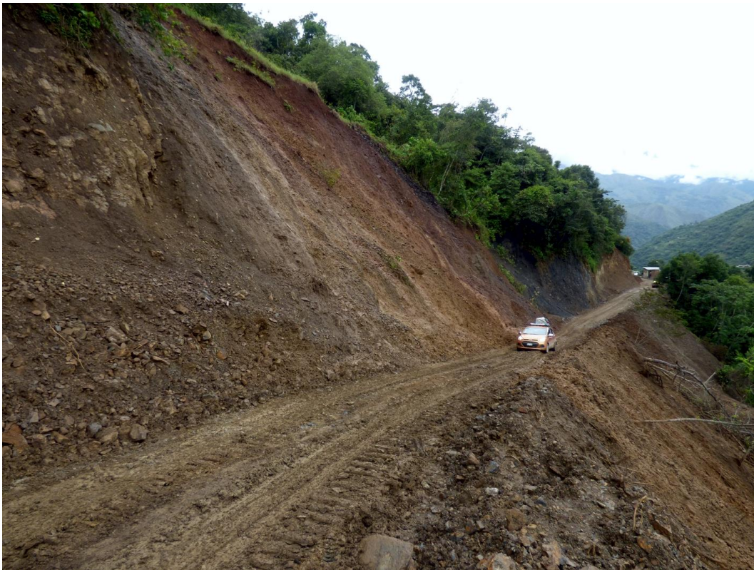
Foto 11: Vista hacia el Oeste donde se puede observar la carretera que carece de una cuneta de evacuación de escorrentía de precipitación pluvial.
