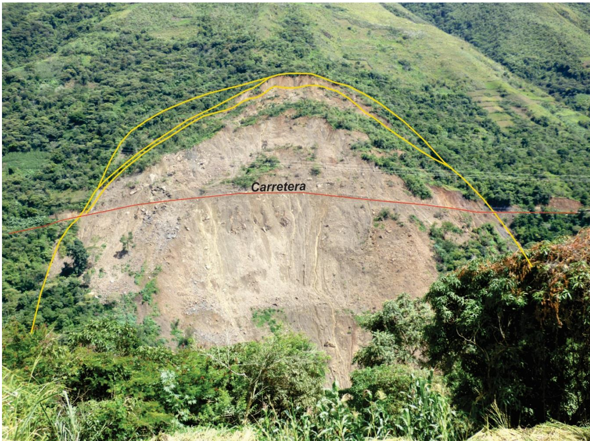
Foto 9: Vista desde el frente del deslizamiento traslacional de Kuquipata en la margen derecha del río Vilcabamba, donde se marcó con línea color amarillo los límites del último evento y en línea color rojo el nuevo tramo de carretera habilitado para permitir el tránsito de vehículos hacia el distrito de Vilcabamba.
