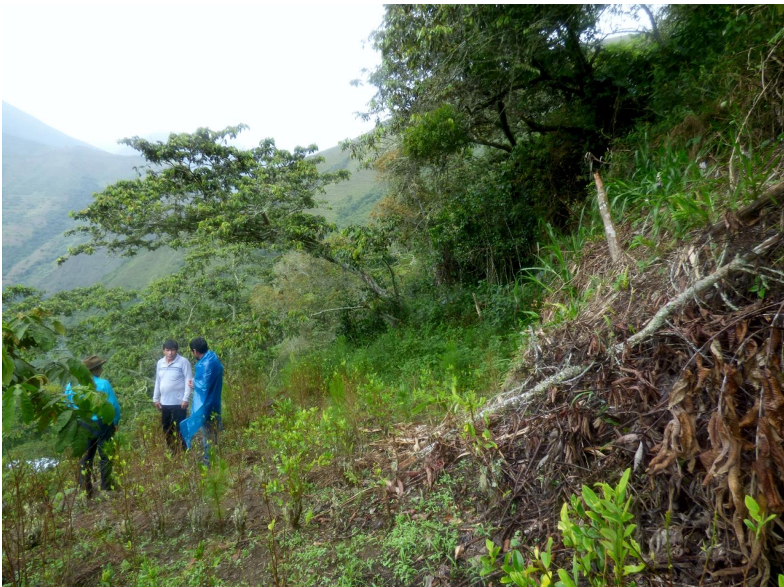
Foto 7: Vista en la que se puede observar la presencia de árboles inclinados que no recuperaron la verticalidad lo cual evidencia movimiento reciente.
