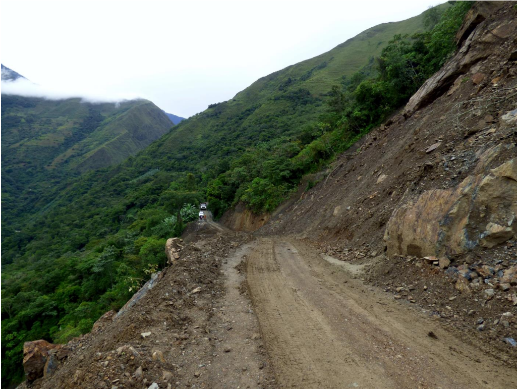
Foto 10: Vista hacia el Este donde se puede observar la nueva plataforma de carretera abierta en el cuerpo del deslizamiento; es posible observar la presencia de material suelto y bloques de roca colgados en el talud superior.
