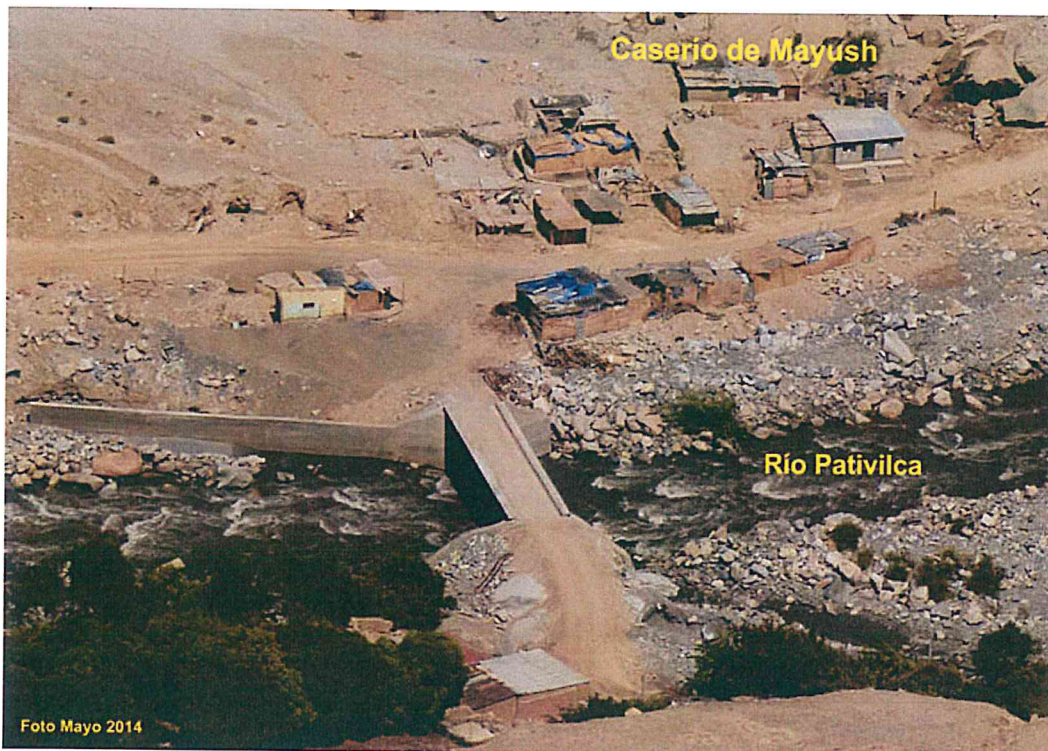
Fotos 27 y 28. Comparaciones del sector de Mayush, antes y después del flujo de detritos.
