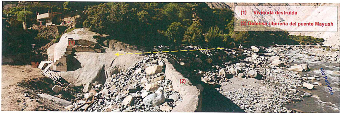
Foto 16. Se muestra el sentido, por donde se desplazó el agua excedente después del embalse, afectó a vivienda.
