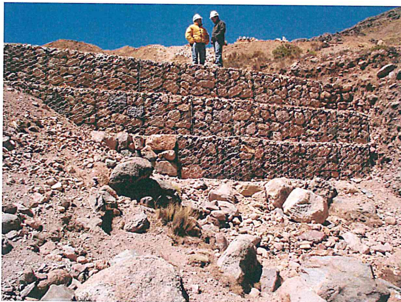
Foto 29. Dique transversal con muro de gaviones en gradería.
