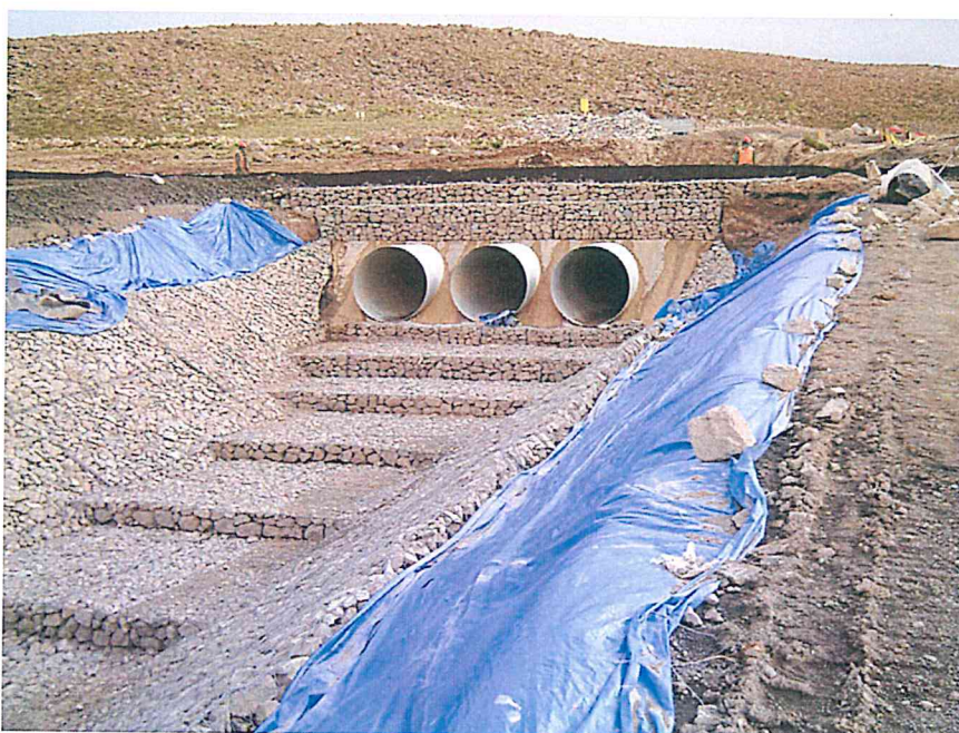
Fotos 31 y 32. Diques "semihuecos" o de retenida selectiva. Con gradería canalizada para pérdida de la energía del flujo en los saltos sucesivos.
