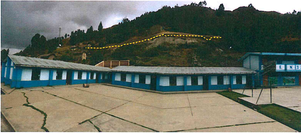
Foto 16. Se aprecia la escarpa en la parte posterior del centro educativo
