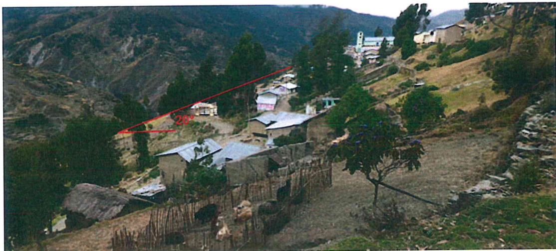
Foto 11. Se muestra la pendiente del terreno.
