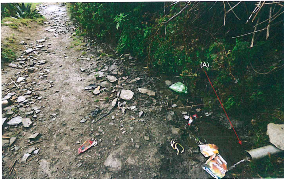
Foto 10. Tubería que ha captado el agua proveniente de un puquial, el cual la vierte al terreno en forma inadecuada.
