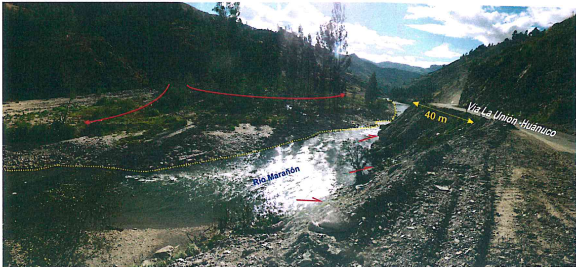
Foto 35. Desembocadura de la quebrada Tingo Chico, se aprecia el depósito en forma de abanico, el estrechamiento del cauce del río, erosión fluvial en la margen derecha y parte del tramo de carretera afectado.
