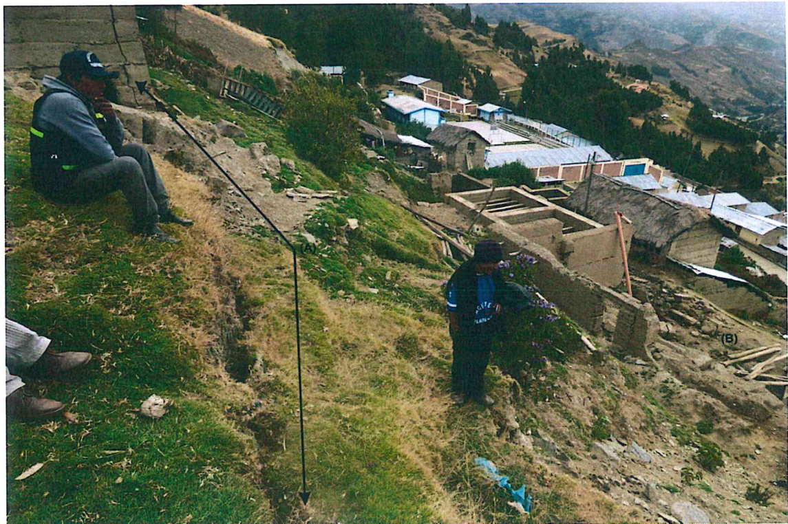
Foto 23. Agrietamiento del terreno (A), y viviendas afectadas por el movimiento del deslizamiento (B).
