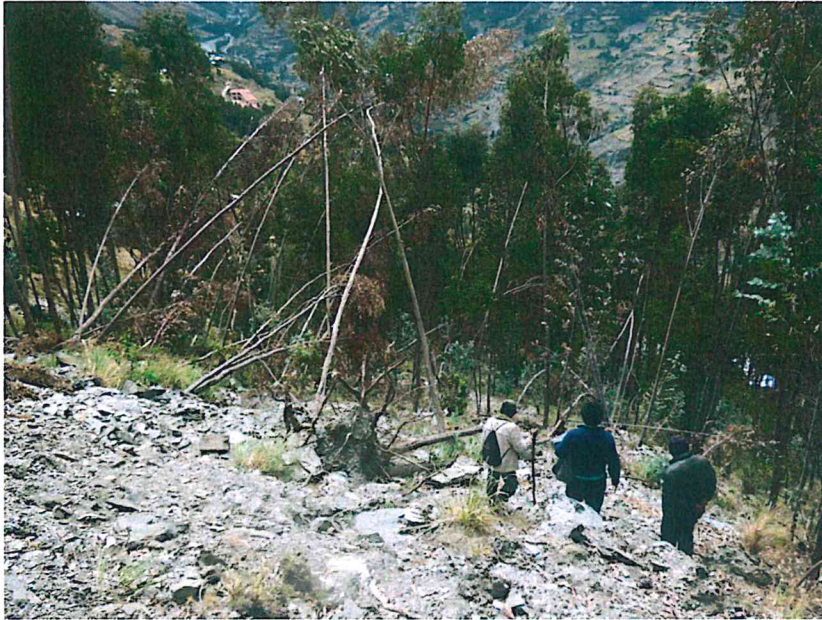
Foto 31. Material proveniente del derrumbe, retenido por los árboles de eucalipto.
