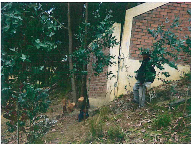
Foto 18 y 19 Pared inclinada del nuevo centro educativo y sostenida por los arboles de eucalipto.
