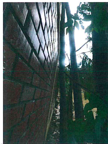
Foto 18 y 19 Pared inclinada del nuevo centro educativo y sostenida por los arboles de eucalipto.
