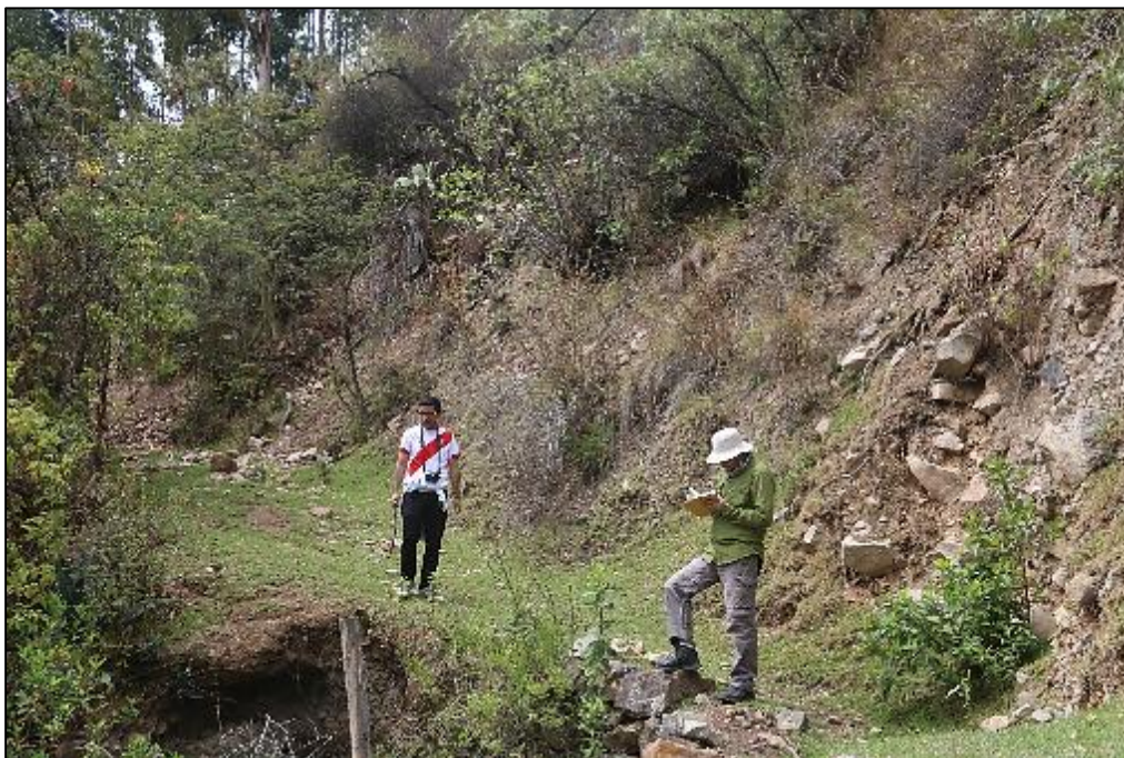
Foto 8: Escarpe de un deslizamiento en vías de reactivación.
