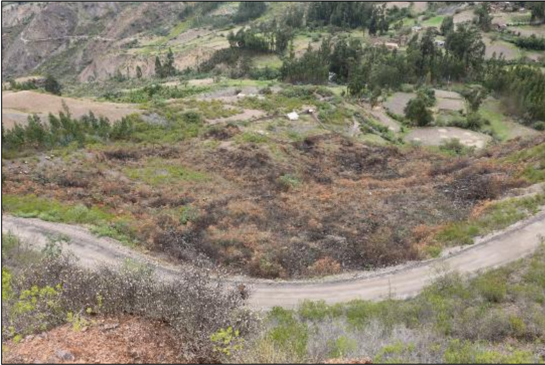
Foto 17: Vista ladera debajo de un deslizamiento reactivado en el Sector 3.
