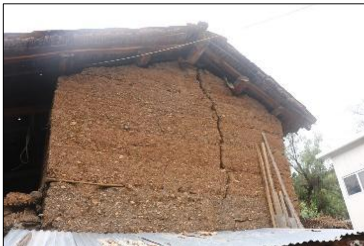
Fotos 12 y 13: Agrietamientos en viviendas aún habitadas de la comunidad campesina San Bernardo de Colpa.
