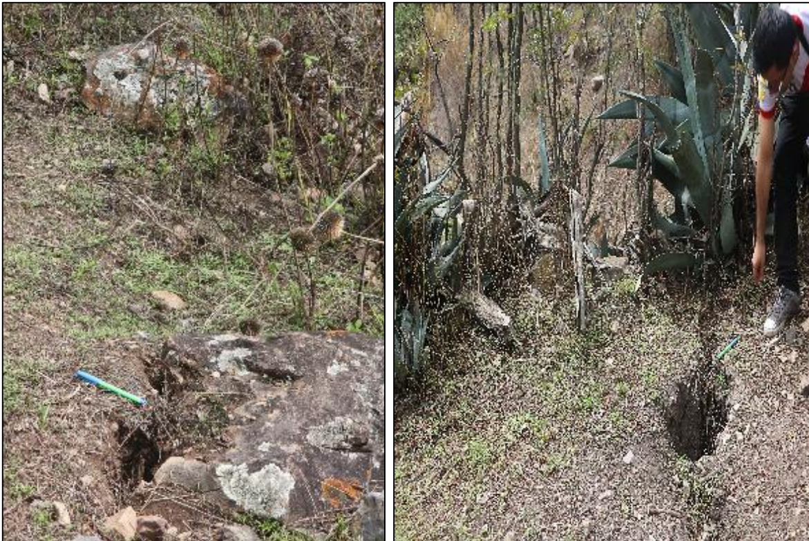
Fotos 9 y 10: Grietas tensionales en el cuerpo del deslizamiento de Colpa.
