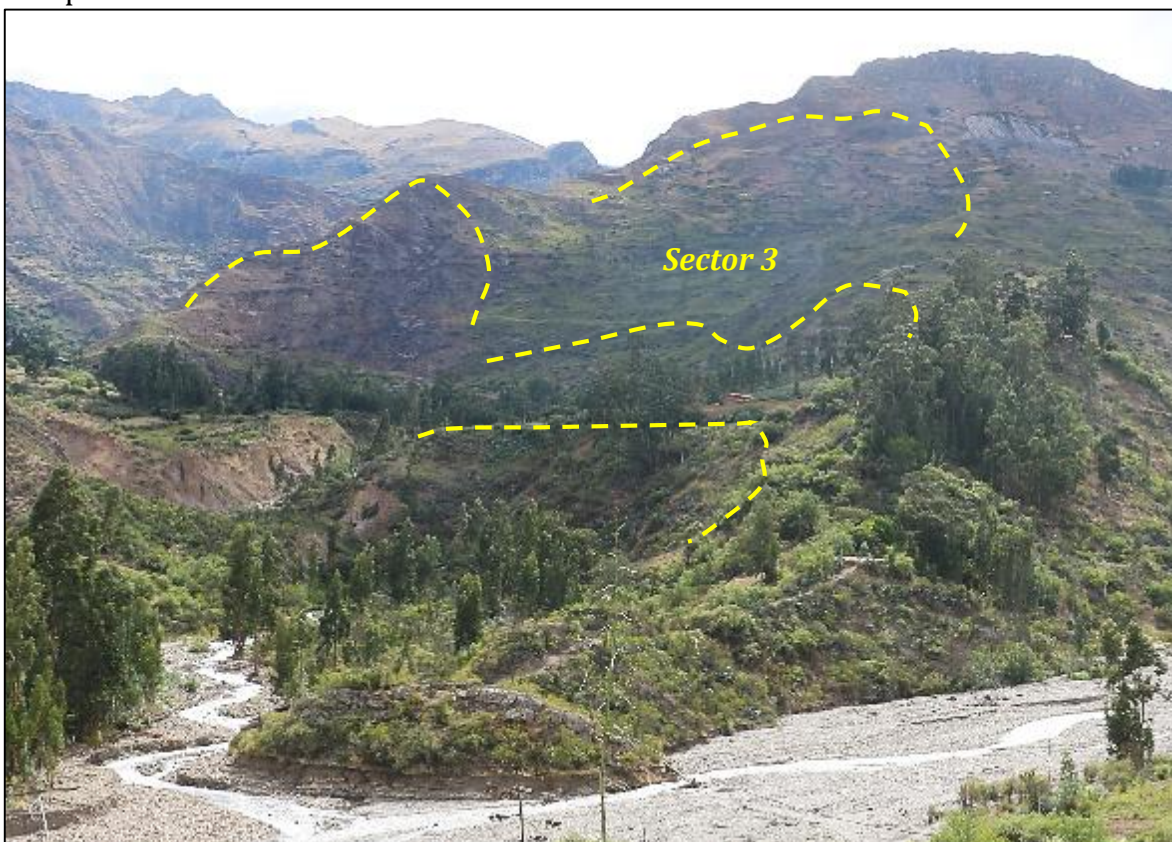
Foto 16: Escarpes de deslizamientos inactivos (parte alta) y reactivaciones (parte baja), en el Sector 3 del área de estudio.
