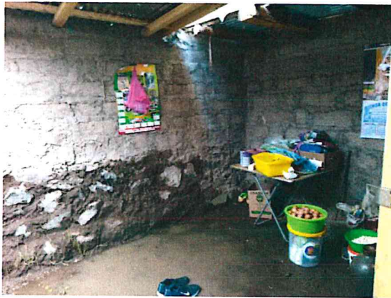
Vivienda afectada por las lluvias, el uso de calaminas sin asesoramiento técnico trae como consecuencias perjudiciales como se aprecia en la foto.
