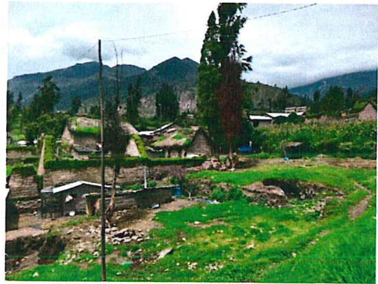
Vías sin sistemas de drenaje que permita la canalización de las aguas, lo que favorece la infiltración y la saturación de suelo afectando las edificaciones de las paredes de adobe.
