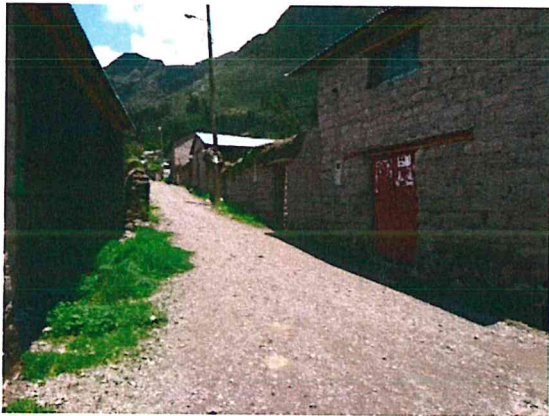
Vías sin sistemas de drenaje que permita la canalización de las aguas, lo que favorece la infiltración y la saturación de suelo afectando las edificaciones de las paredes de adobe.
