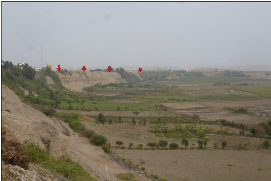
Figura 40: Acantilados con longitudes de hasta 2.6 km en el extremo sur de la ciudad de Barranca, entre la playa Bandurria hasta playa Colorado. La ocurrencia de derrumbes es debido a la fuerte pendiente del terreno
