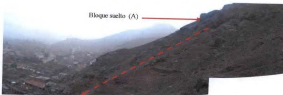
Foto 6.- Se muestra la posible caída libre del bloque de roca.
