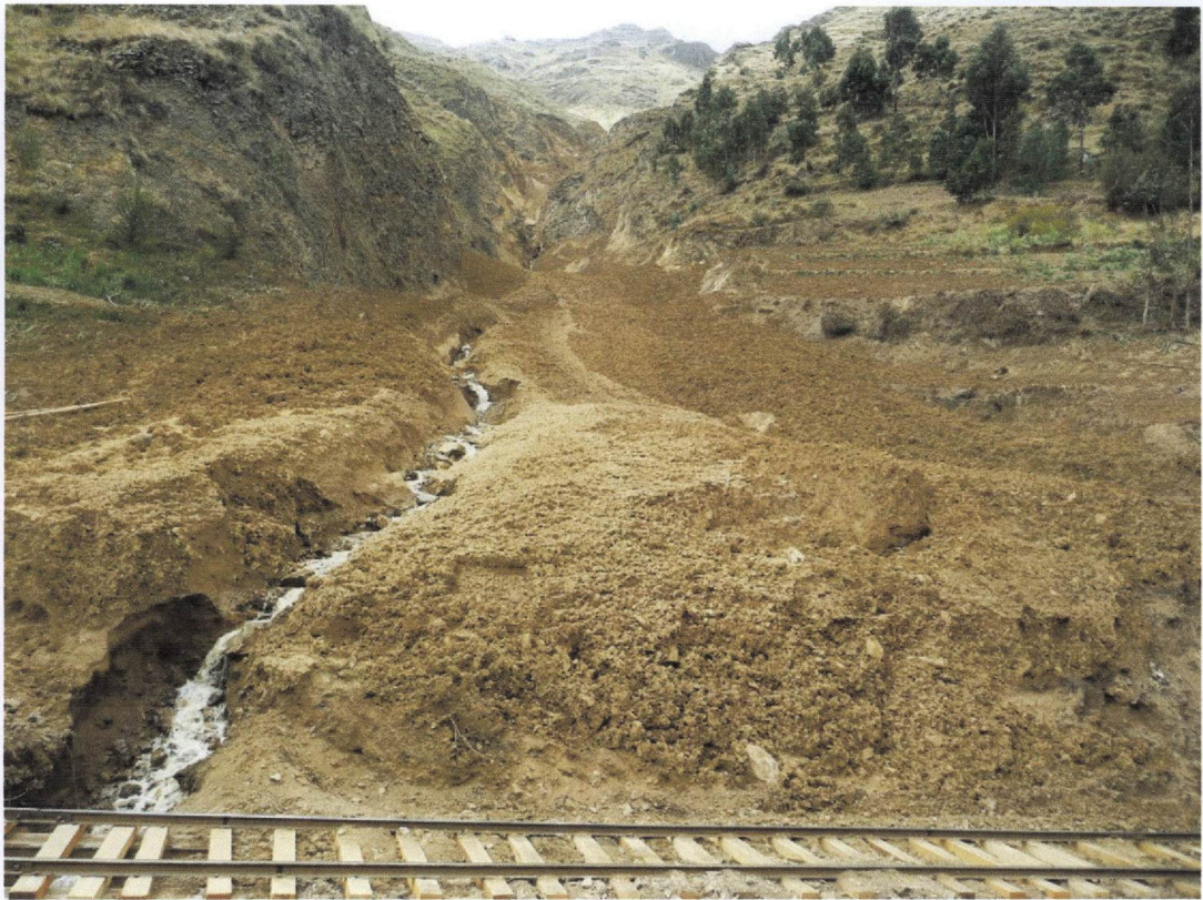
Foto 5. Cauce actual de la quebrada Relavera
