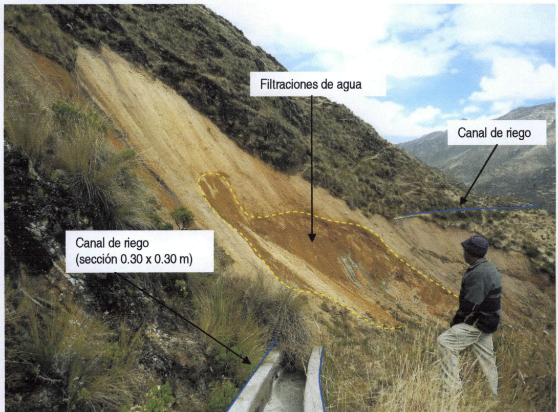
Foto N° 4. Filtraciones de agua en la pared de la escarpa del deslizamiento.
