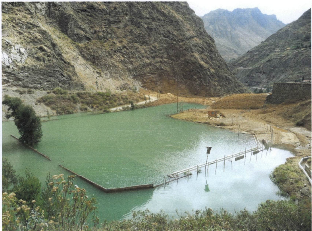
Foto N° 8. Inundación por represamiento de cauce del río Blanco que afectó al criadero de Truchas
