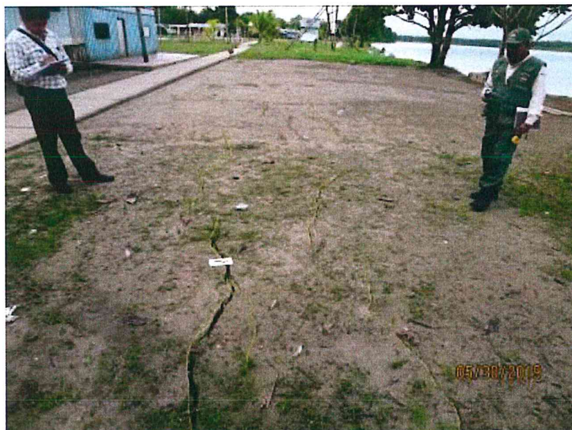
Figura 8. Vista tomada del barrio alto con dirección sureste, se observa grietas con longitud 1 a 10 m, aberturas entre 0.1 a 3 cm.
