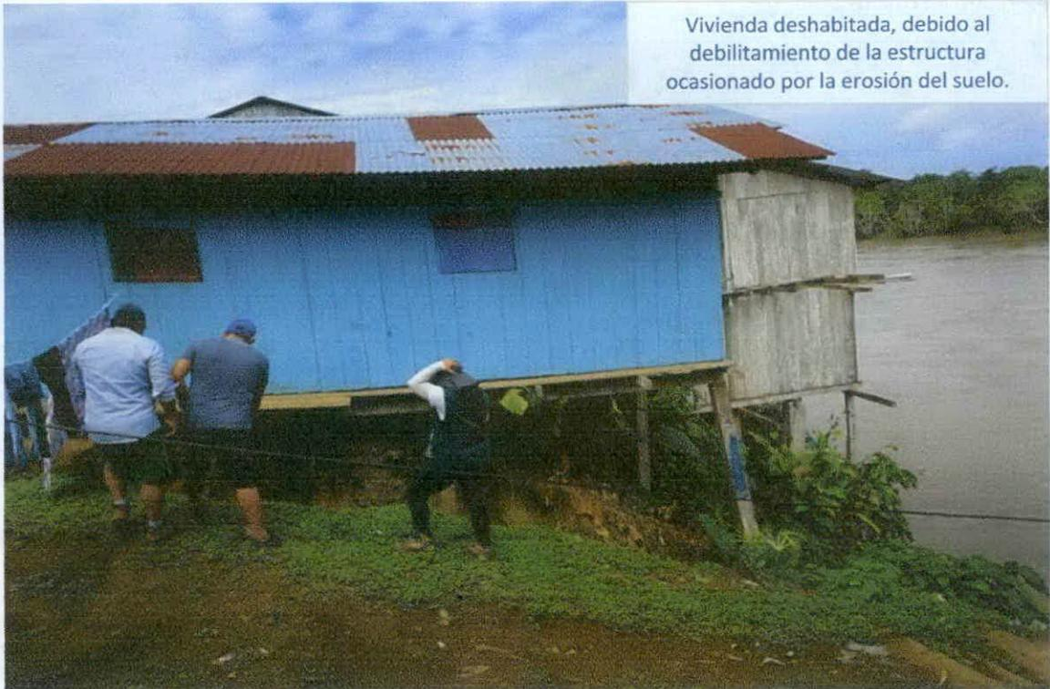
Vivienda deshabitada, debido al debilitamiento de la estructura ocasionado por la erosión del suelo.
