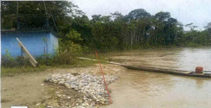
Fotografía 1. Caseta de captación de agua inoperativo, afectado por la inundación y la erosión del suelo.
