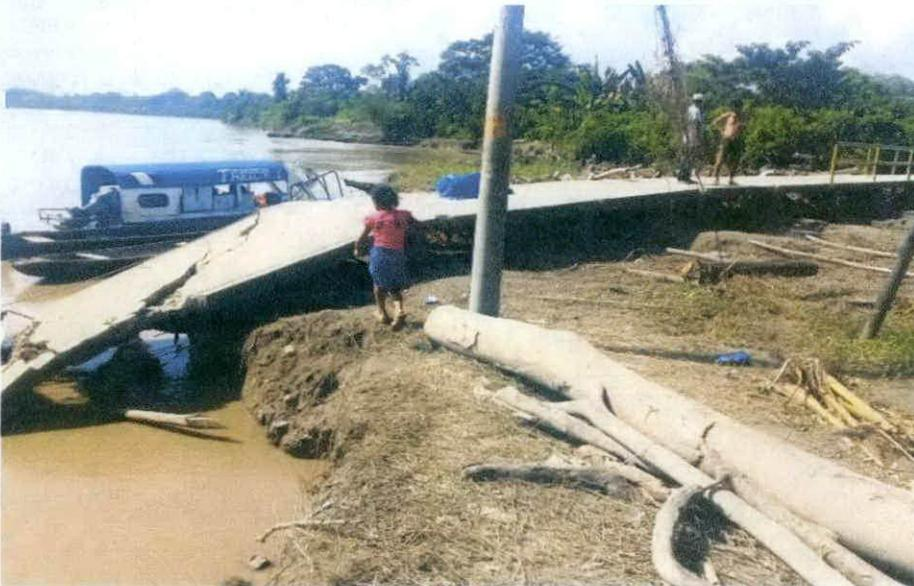
**Fotografía 5.** Puente peatonal afectado por la erosión y desbarrancamiento del suelo.
