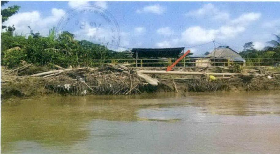
**Fotografía 6.** Postes de concreto para cableado eléctrico caídos debido al arrastre de escombros y erosión del suelo.
