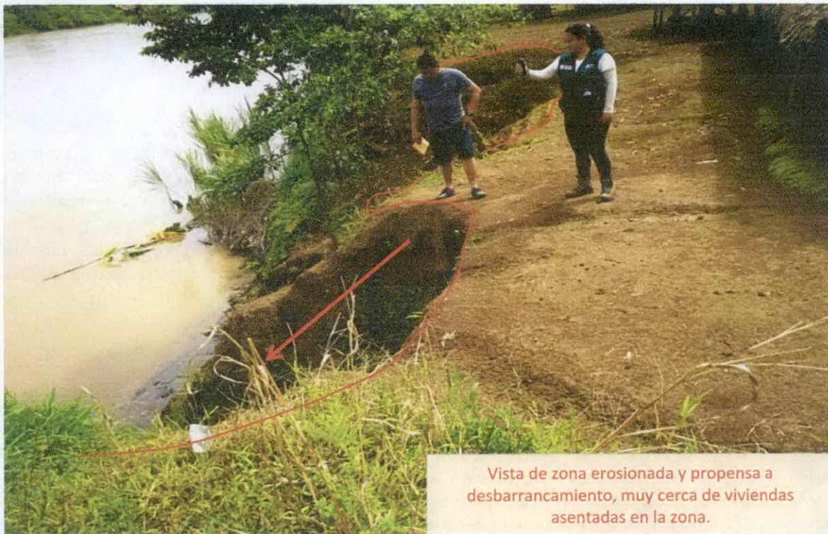
Vista de zona erosionada y propensa a desbarrancamiento, muy cerca de viviendas asentadas en la zona.
