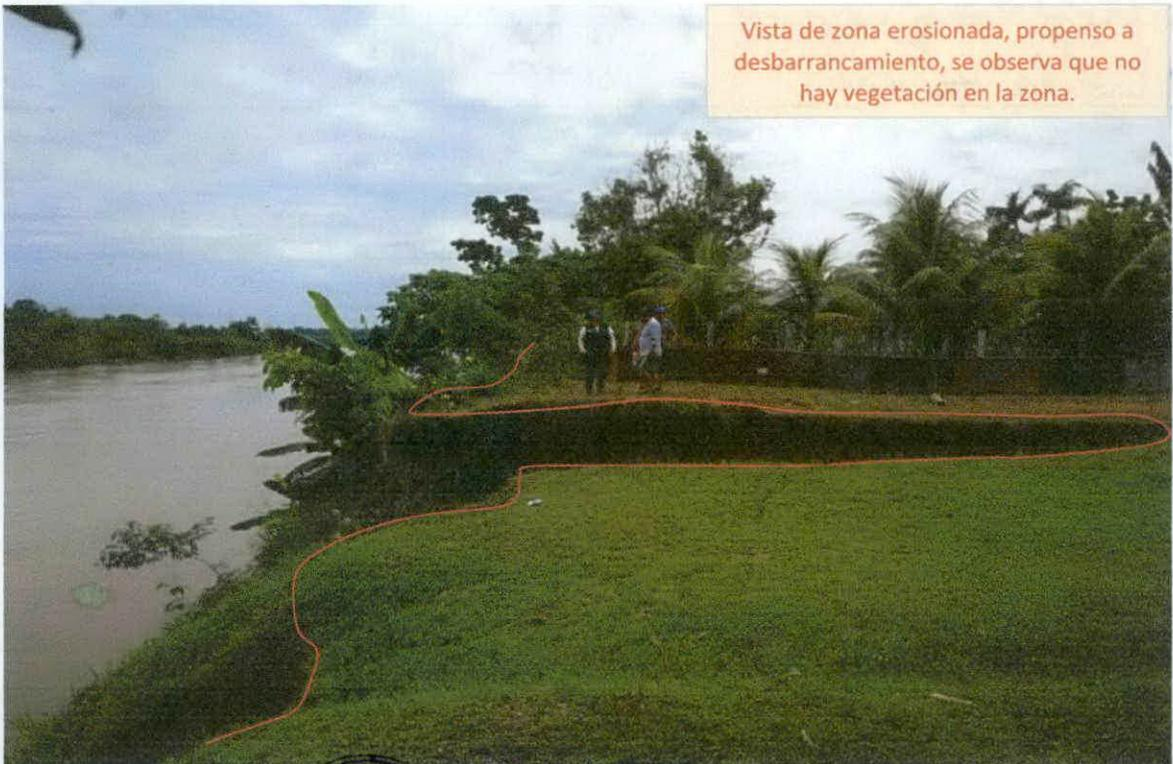
Vista de zona erosionada, propenso a desbarrancamiento, se observa que no hay vegetación en la zona.
