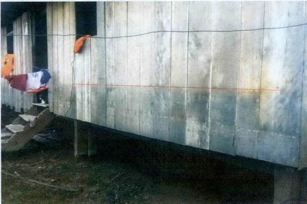
Fotografía 2. Vista de nivel del agua alcanzado en las viviendas afectadas
