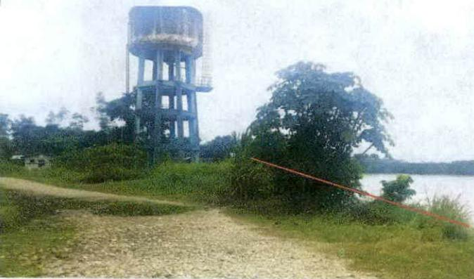
Fotografía 5. Vista de tanque elevado que viene siendo alcanzado por el nivel de erosión del suelo.
