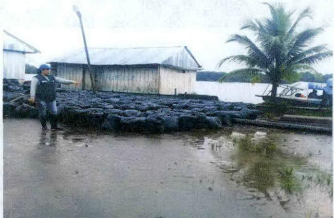
Fotografía 4. Los pobladores realizaron el llenado de sacos con arena y los apilaron a modo de barrera de contención. La medida no funcionó optimamente.
