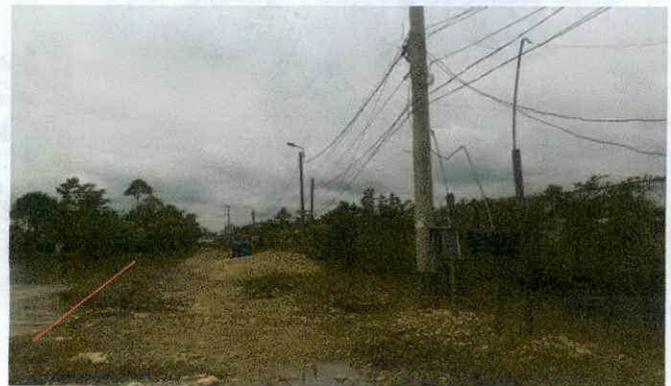
Fotografía 6. Postes de alumbrado público y cableado eléctrico muy cerca a la margen del río.
