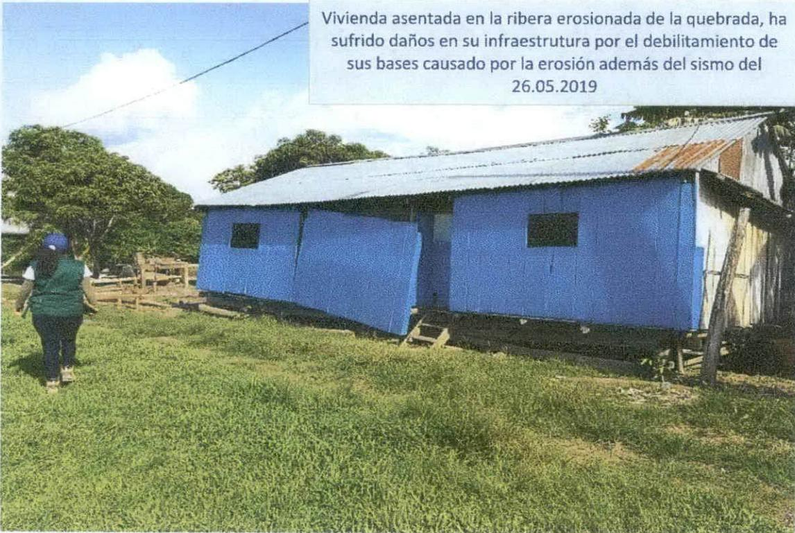
Vivienda asentada en la ribera erosionada de la quebrada, ha sufrido daños en su infraestructura por el debilitamiento de sus bases causado por la erosión además del sismo del 26.05.2019
