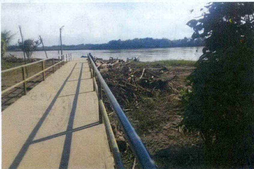
**Fotografía 3.** Vista del puente peatonal que ha sufrido daños en su estructura debido al arrastre de material que golpea las bases del puente.
