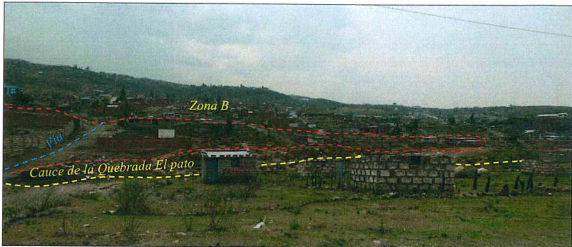
Figura 26. Villa Confraternidad, zona B. Muestra viviendas sobre material de relleno (líneas color rojo). Además de observa una vía que cruza la quebrada (líneas celestes). Vista hacia el este.
