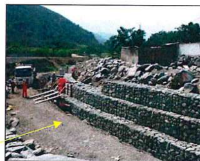
Figura 29. Ejemplo de muro de contención, tipo gaviones, que podría ser construido en los alrededores de las viviendas de la zona A.
