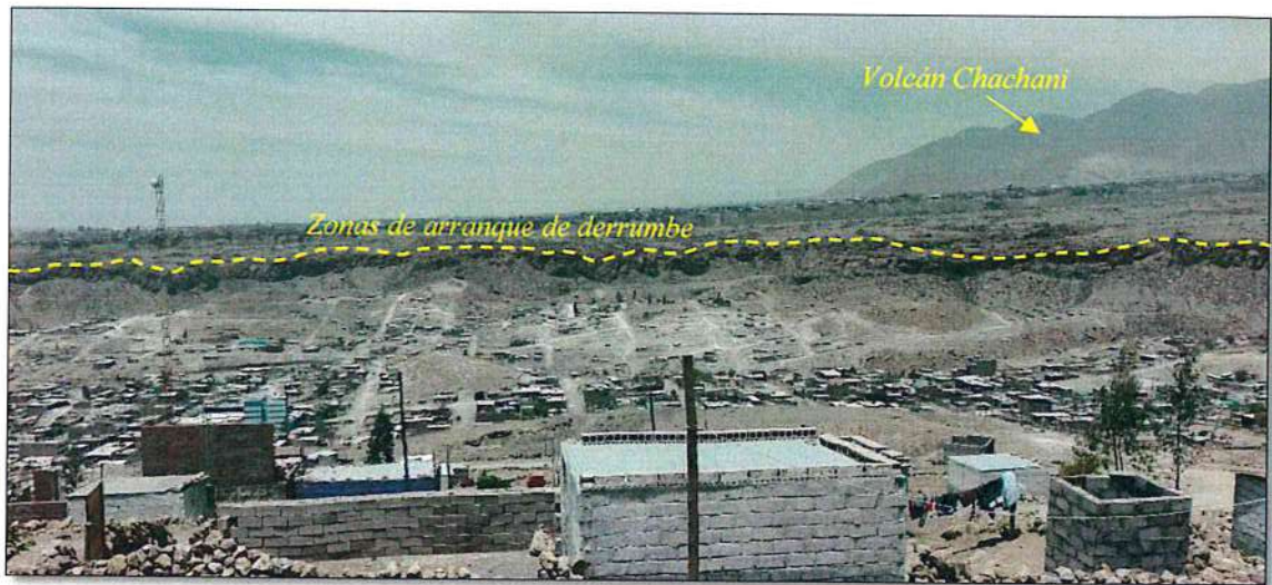
Figura 24. Vista hacia el noroeste que muestra zonas de arranques de derrumbes y viviendas asentadas al pie del talud de la margen derecha de la quebrada El Pato.
