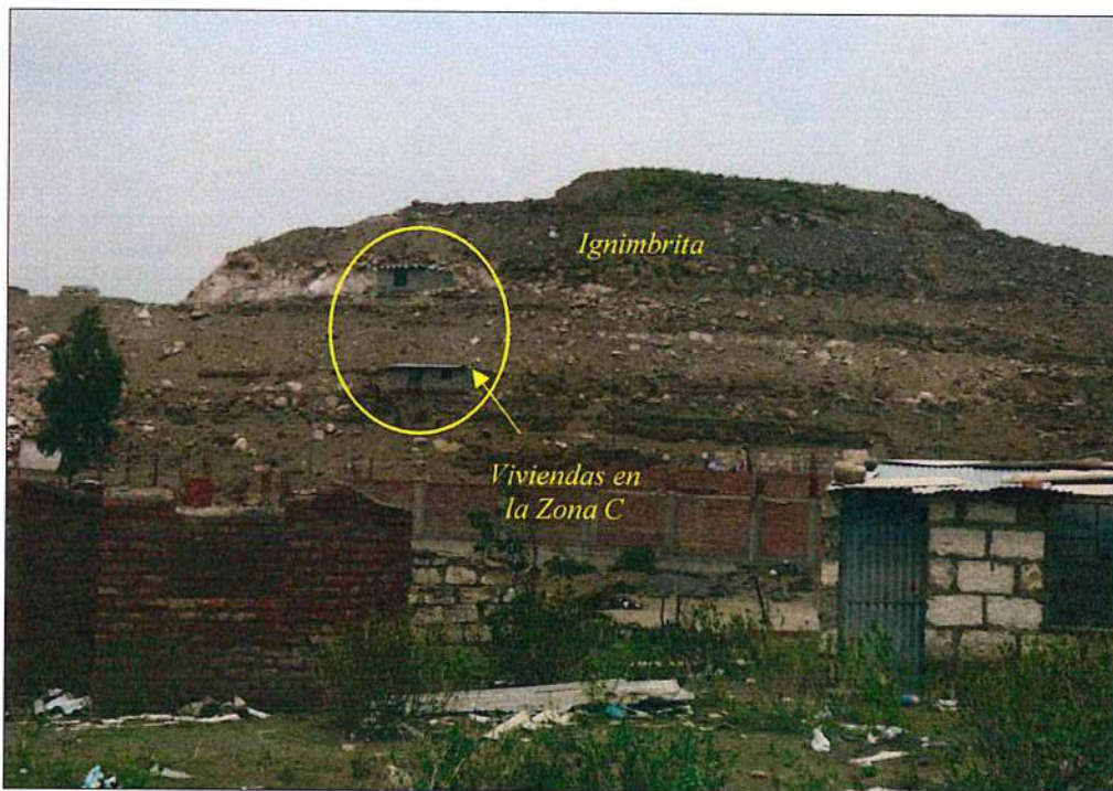
Figura 22. Muestra viviendas de la zona C, situadas en la ladera de la quebrada El Pato (circulo color amarillo).
