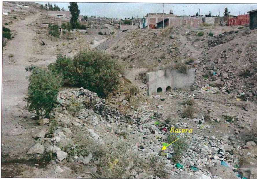
Figura 20. Muestra depósitos de basura en la quebrada El Pato.
