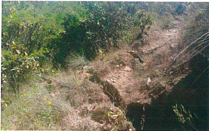
Fotografía 8: Grietas con dirección N320°.
