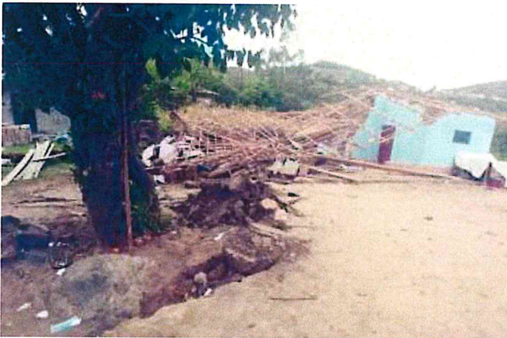
Fotografía 14. Vivienda colapsada debido al agrietamiento del terreno.
