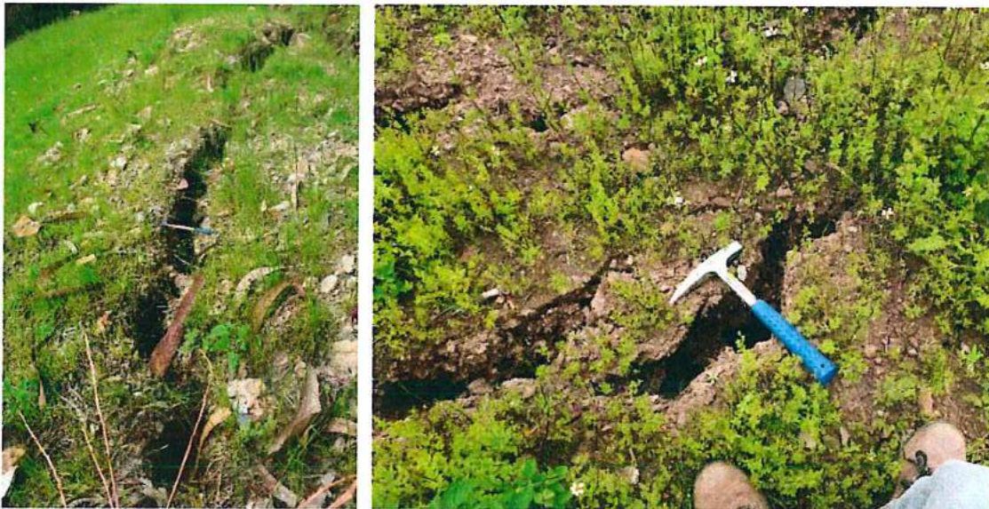
Fotografías 10 y 11. Grietas tensionales de apertura 0.10 m a 0.15 m dispuestas transversal y longitudinalmente a lo largo del deslizamiento.
