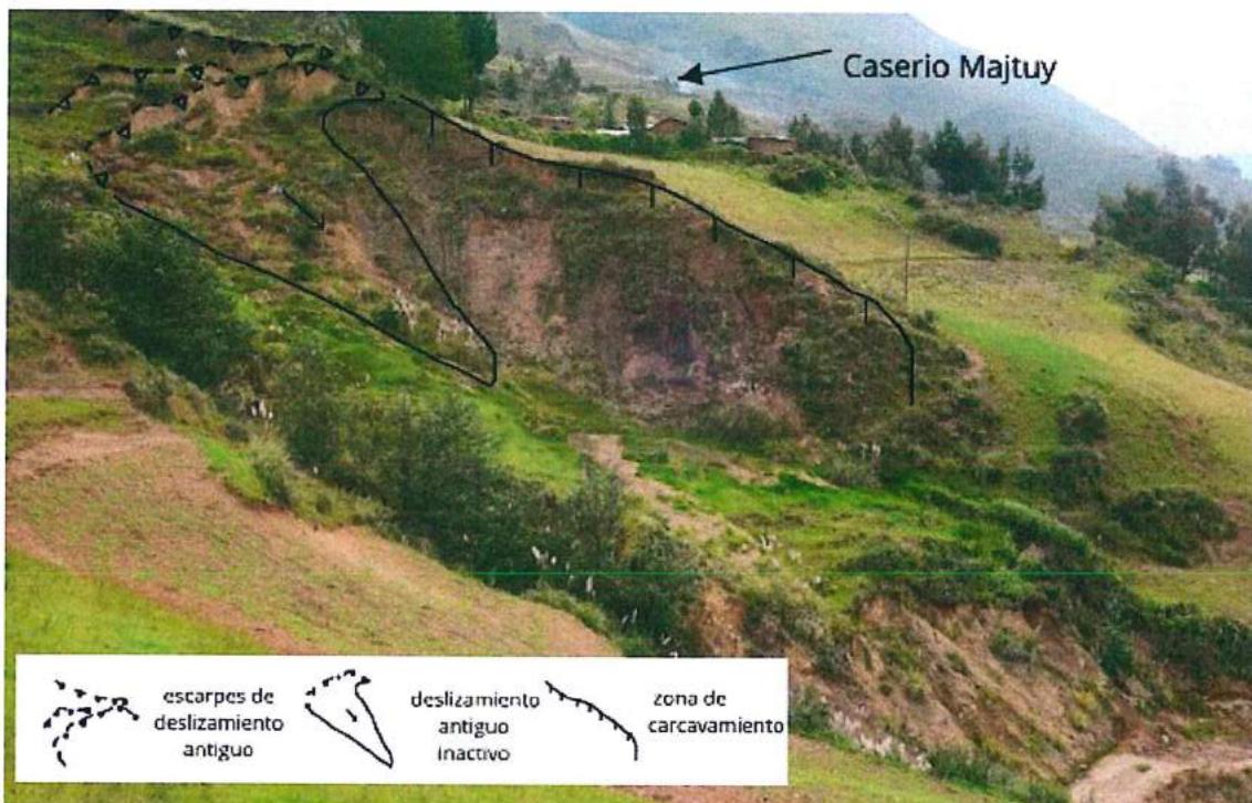
Figura 15. Deslizamiento inactivo observado al NE del caserío Majtuy.
