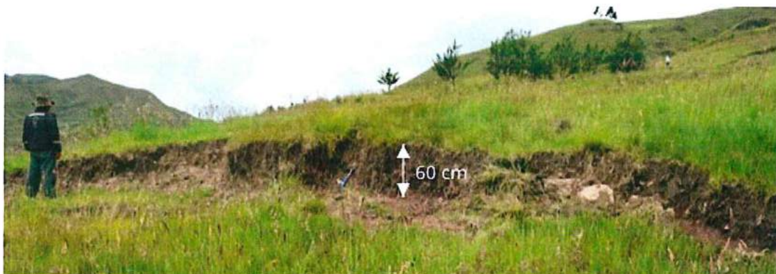
Figura 11. Escarpe principal del deslizamiento con saltos que varían de 0.90 m a 1.10 m.
