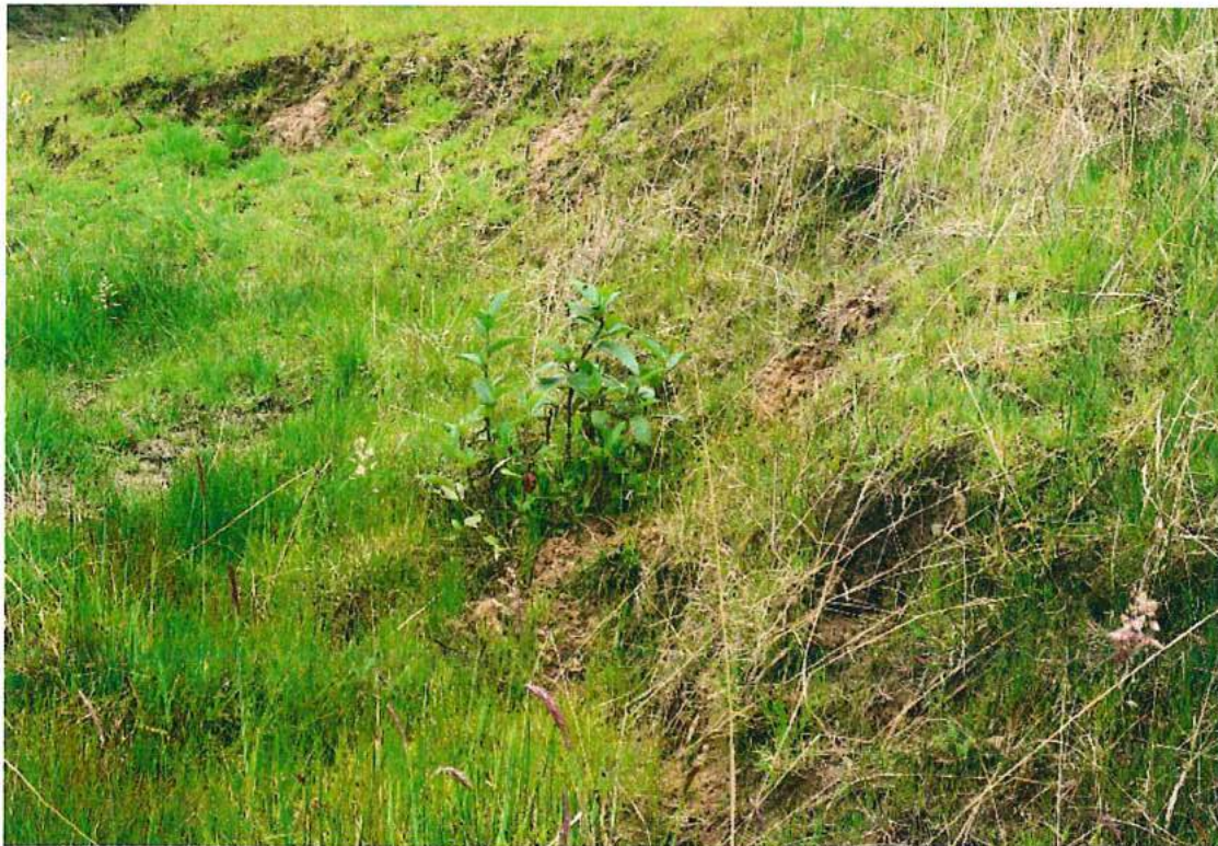
Fotografía 5. Se muestra un tercer escarpe dentro del cuerpo del deslizamiento.
