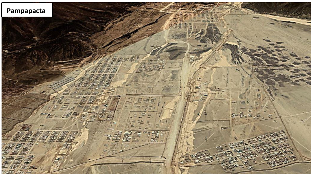
Figura 5. Vista del Google Earth, se observa el recorrido del huaico del 15 de marzo de 2017 que discurrió por la quebrada Malanche en el sector Pampa Pacta.
