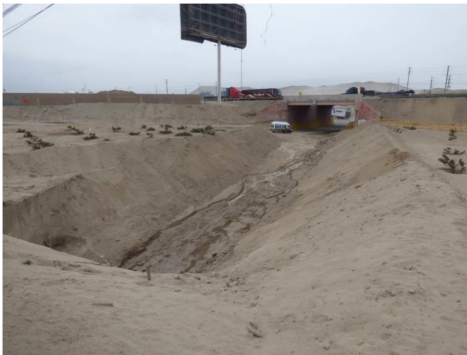
Fotografía 11. Vista al noreste, aguas arriba del cauce de la quebrada Río Seco, el cual corta la carretera Panamericana Sur (km 44+500) y acceso a Punta Hermosa
