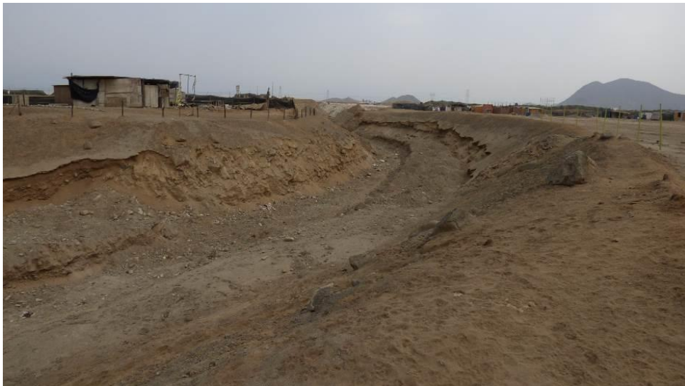
Fotografía 9. Cauce de la quebrada Malanche, aguas abajo, sector Pampa Pacta. Vista al suroeste
