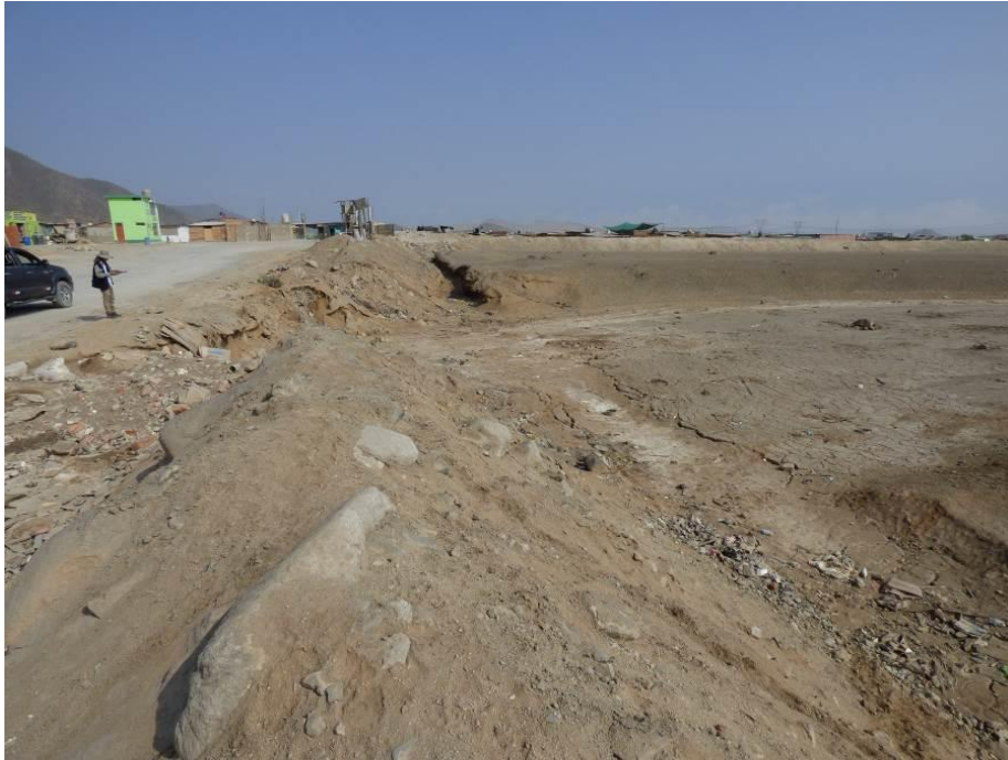
Fotografía 10. Vista al suroeste, aguas abajo del cauce de la quebrada Río Seco obstruida por viviendas del centro poblado Santa Rosa
