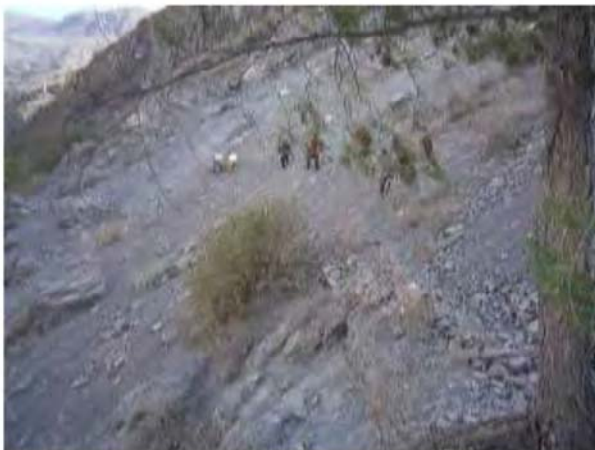
Foto N° 8: Derrumbes sobre el canal que discurre en conducto cubierto. Zona crítica.
