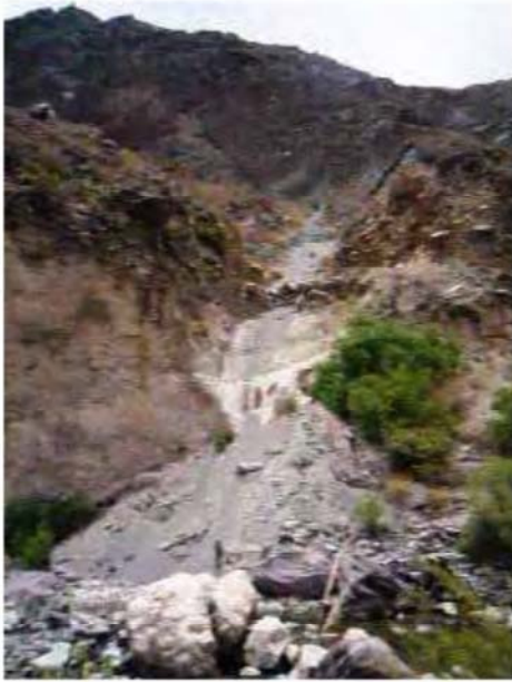
Foto N° 2. Derrumbes, desprendimientos de rocas y flujos en épocas de fuertes precipitaciones.
