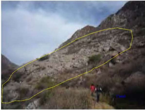
Foto N° 10. Deposito de derrumbes, obsérvese los grandes bloques sueltos.
