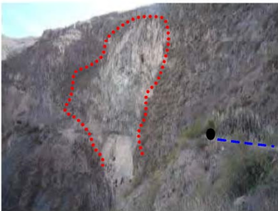
Foto N° 9 derrumbes y desprendimiento de rocas, en la ladera del túnel N° 12. Este en su progreso, puede provocar el colapso del túnel
