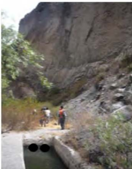
Foto N° 6. Tramo con dos tubos de 21", tubería que se obstruye con los derrumbes.
