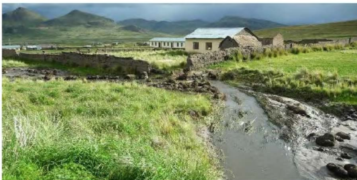
Foto N° 13. Muro perimétrico de la Institución Educativa Primaria 70251
