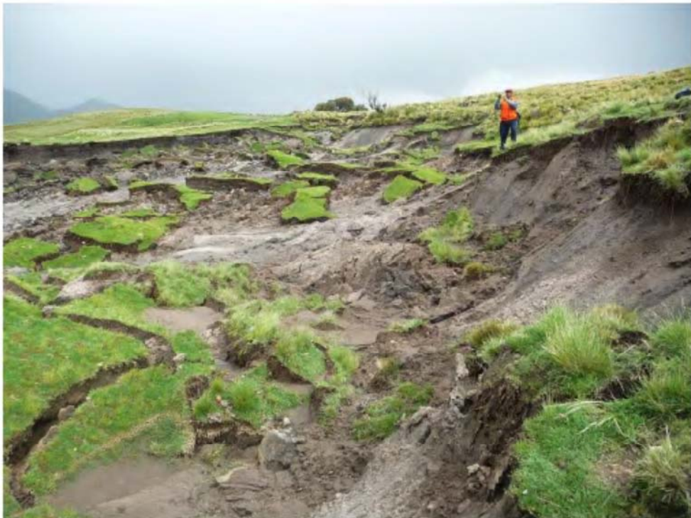
Foto N° 7. Vista de la escarpa del deslizamiento, obsérvese las “champas” de vegetación nativa y material orgánico
