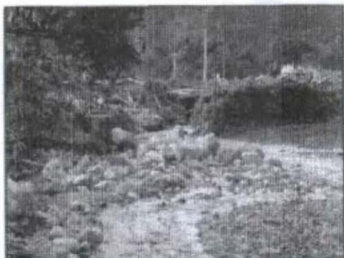
**Foto:** Puente Huacará que se obstruyó con palizada y flujos de detrito (huaycos).
