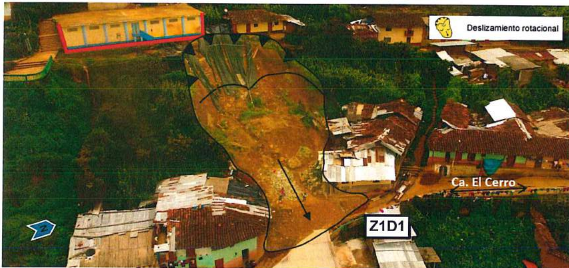
Figura 10. Vista aérea del deslizamiento de tipo rotacional.
