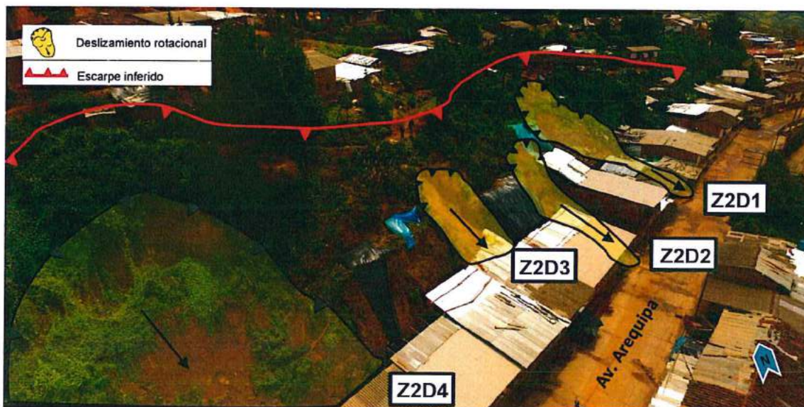
Figura 20. Vista tomada de sur a norte, deslizamientos con zonas de depositación que llegan hasta la Av. Arequipa.
