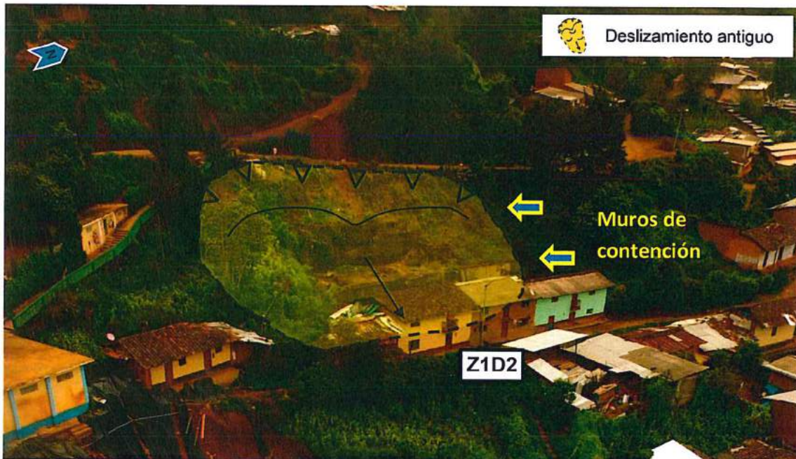
Figura 15. Vista frontal del deslizamiento antiguo entre la Vía de Evitamiento y Ca. El Cerro.
