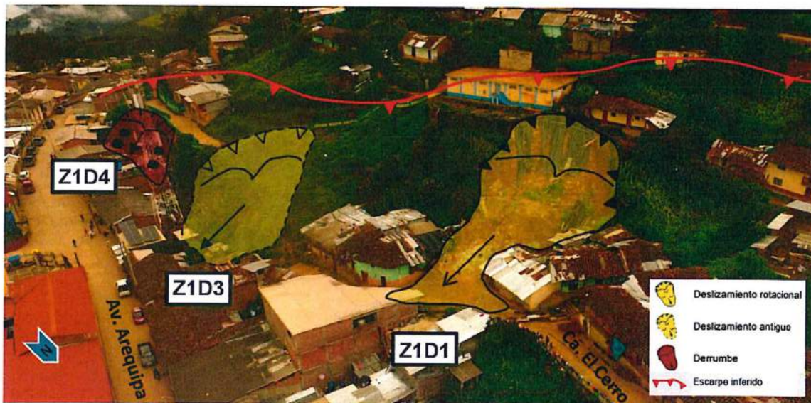
Figura 11. Vista lateral de los deslizamientos en sector el Cerro.
