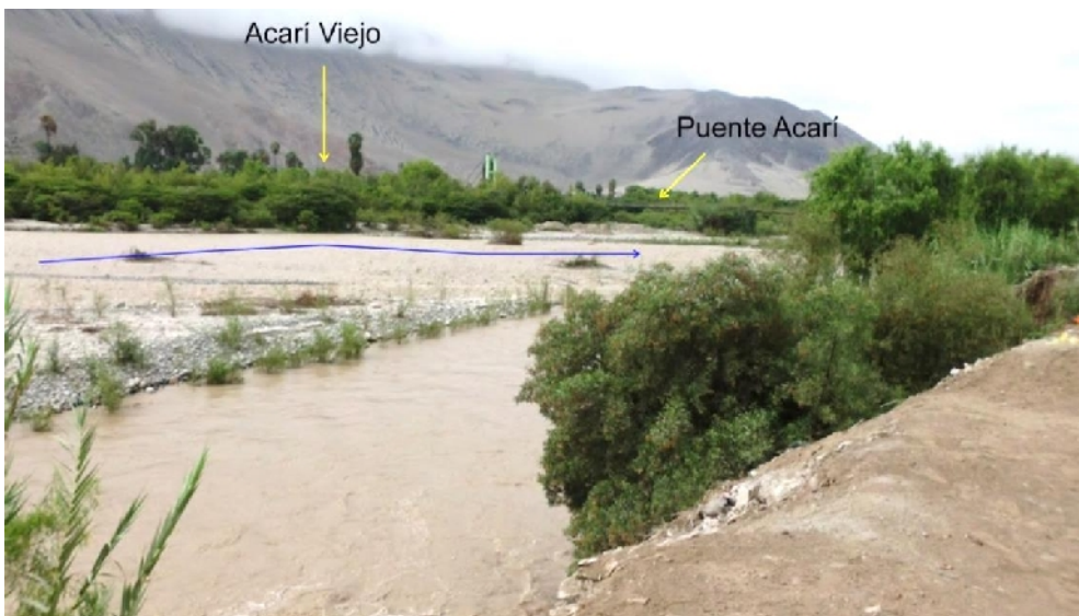
Figura 43: Río Acarí cuyas aguas fluyen de NE a SO. Las zonas urbanas de Acarí y Acarí Viejo se ubican sobre la margen derecha e izquierda del río respectivamente, la estructura más importante es el puente que conecta ambas ciudades.
