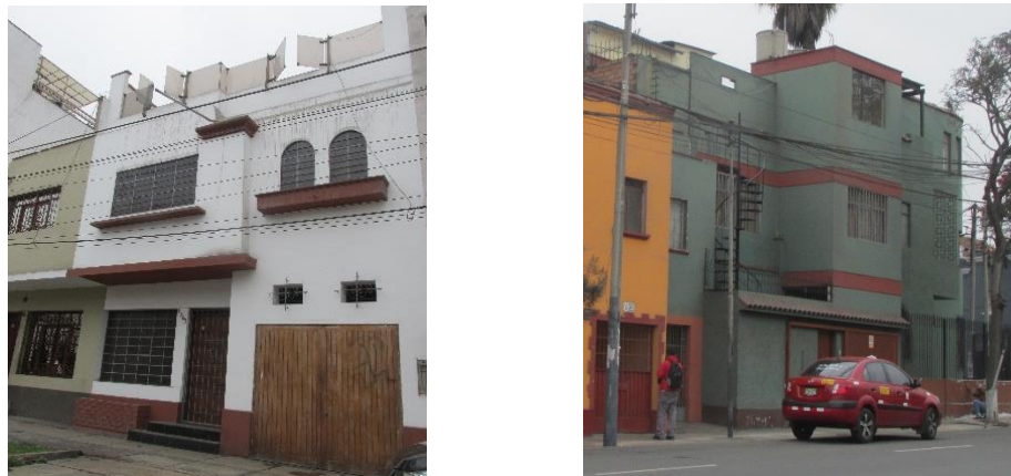
Figura 5. Edificaciones del sector 1; vivienda de mampostería de dos y pisos
