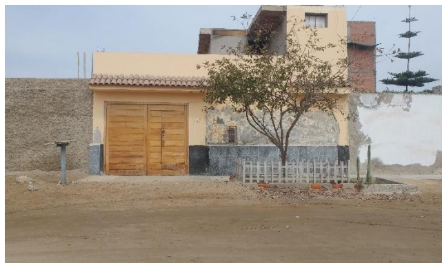
Figura 13. Viviendas del sector 03
