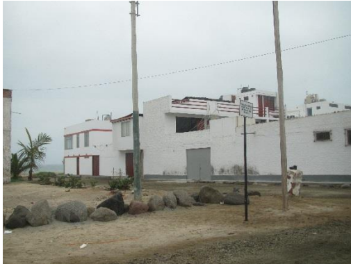
Figura 9. Viviendas del Sector 02
