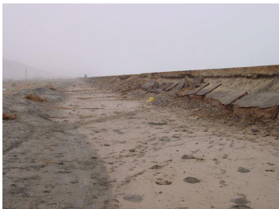
Figura 52. La erosión producto del tsunami del 23 de junio del año 2001 en la playa la Punta-Camaná, la altura máxima de ola en esta zona fue hasta de 7.5m (izquierda) (ITST, 2001a). Un bote pesquero arrastrado 1.3km en la zona donde la inundación llegó a 2km producto del tsunami del 15 de agosto de 2007 (derecha) (Fritz et al., 2008).
