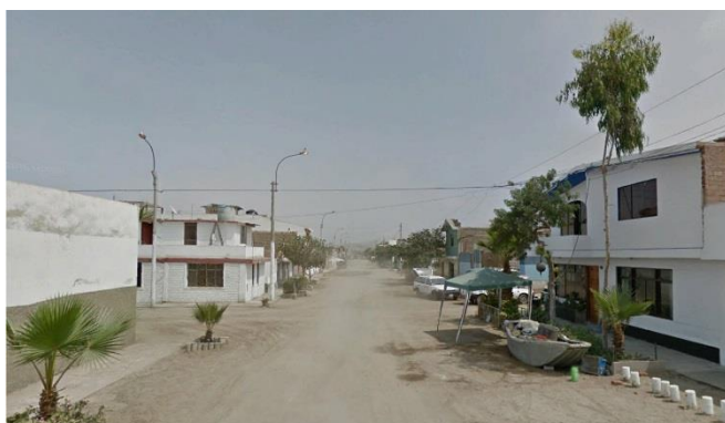
Figura 5. Viviendas del sector 1.
